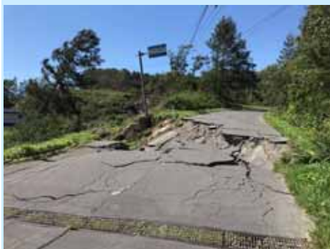
①道路側面での斜面崩壊により 生じた道路の陥没(桜岡地区)
