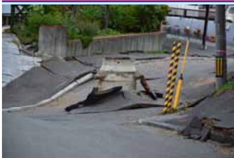
①液状化による土砂流出で陥没したマンホール周辺地盤
