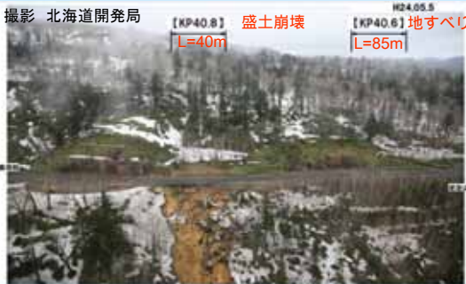
国道230号(中山峠):平成24年5月に発生した盛土崩壊等の様子。
