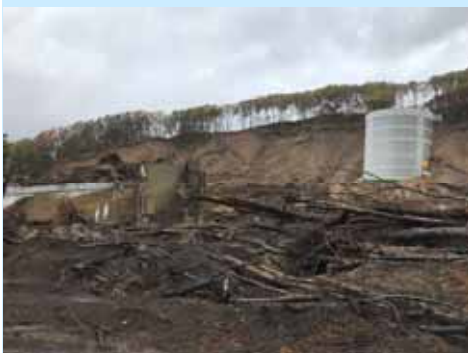
④富里浄水場の斜面崩壊に よる施設被害
