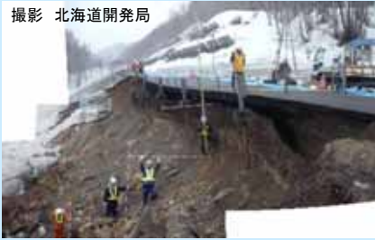
国道230号(中山峠):平成25年4月に発生した盛土崩壊の様子
