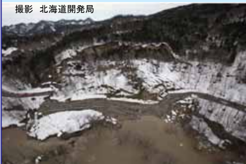
国道239号(霧立峠):平成24年4月に発生した地すべりの様子。
