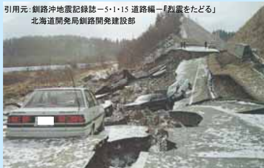
1993年釧路沖地震による道路盛土の被害
