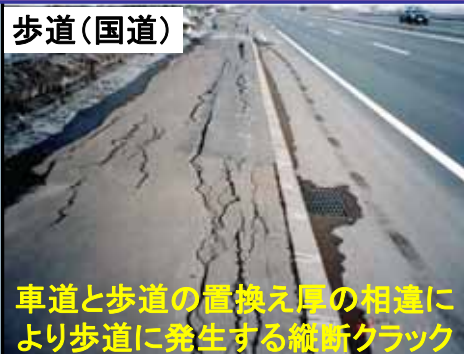
舗装面に発生する凍上量の相違による路面の縦断・横断クラック
