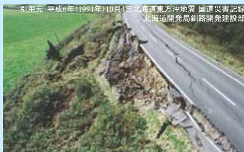
1994年北海道東方沖地震による道路盛土の被害
