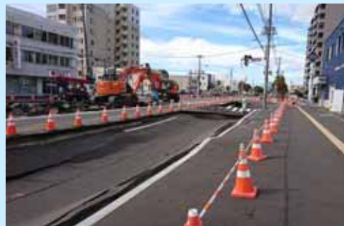
②道路の大規模沈下
