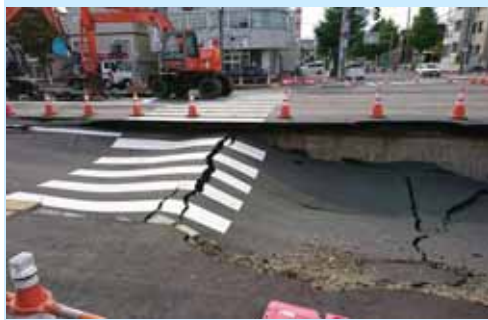
①道路の大規模沈下
