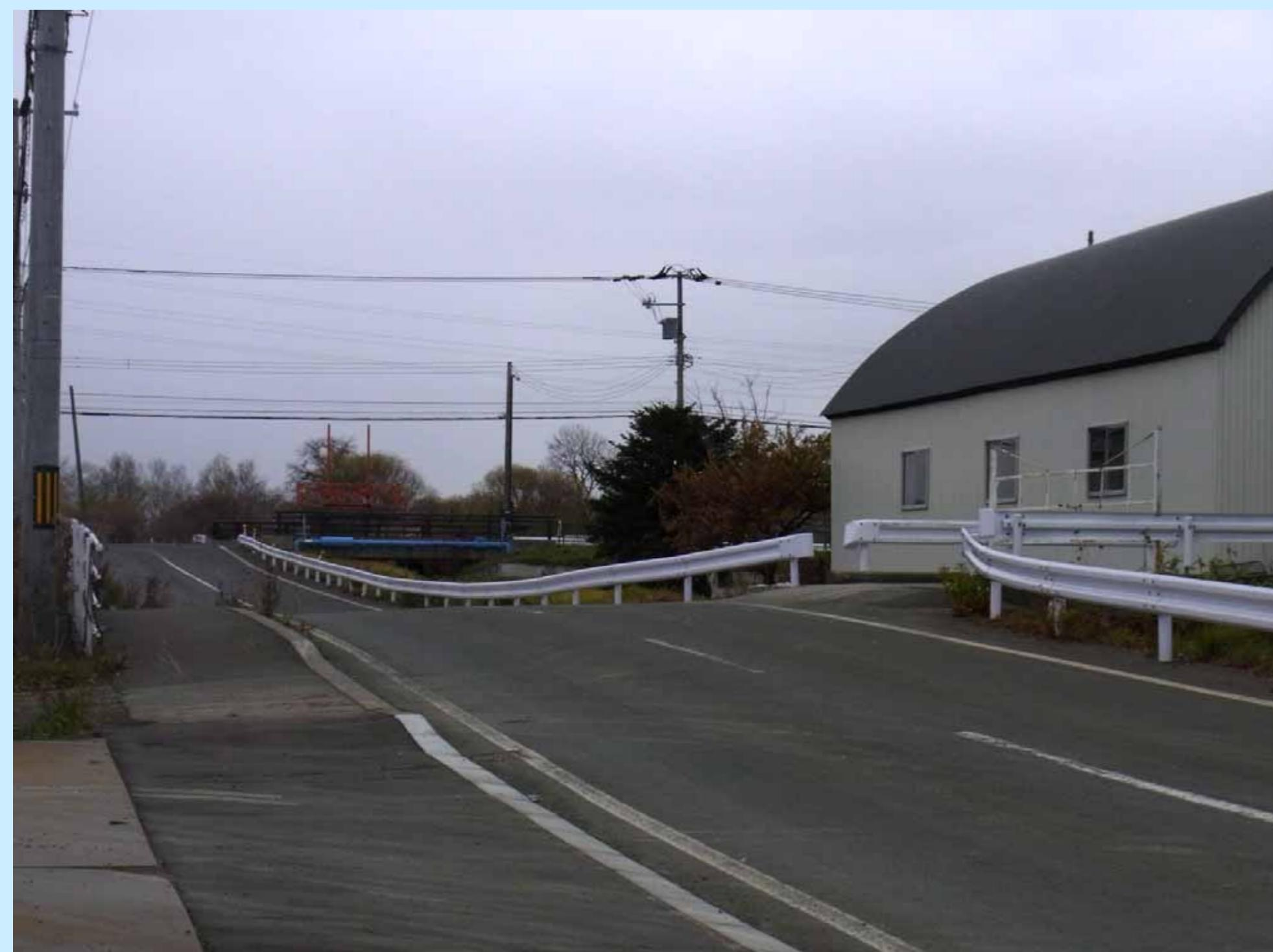
泥炭は、舗装など比較的軽量な構造物の敷設に対しても非常に大きく圧縮し、長期にわたって地表面の沈下を引き起こします。波打った道路はこのような地盤沈下の現れです。
