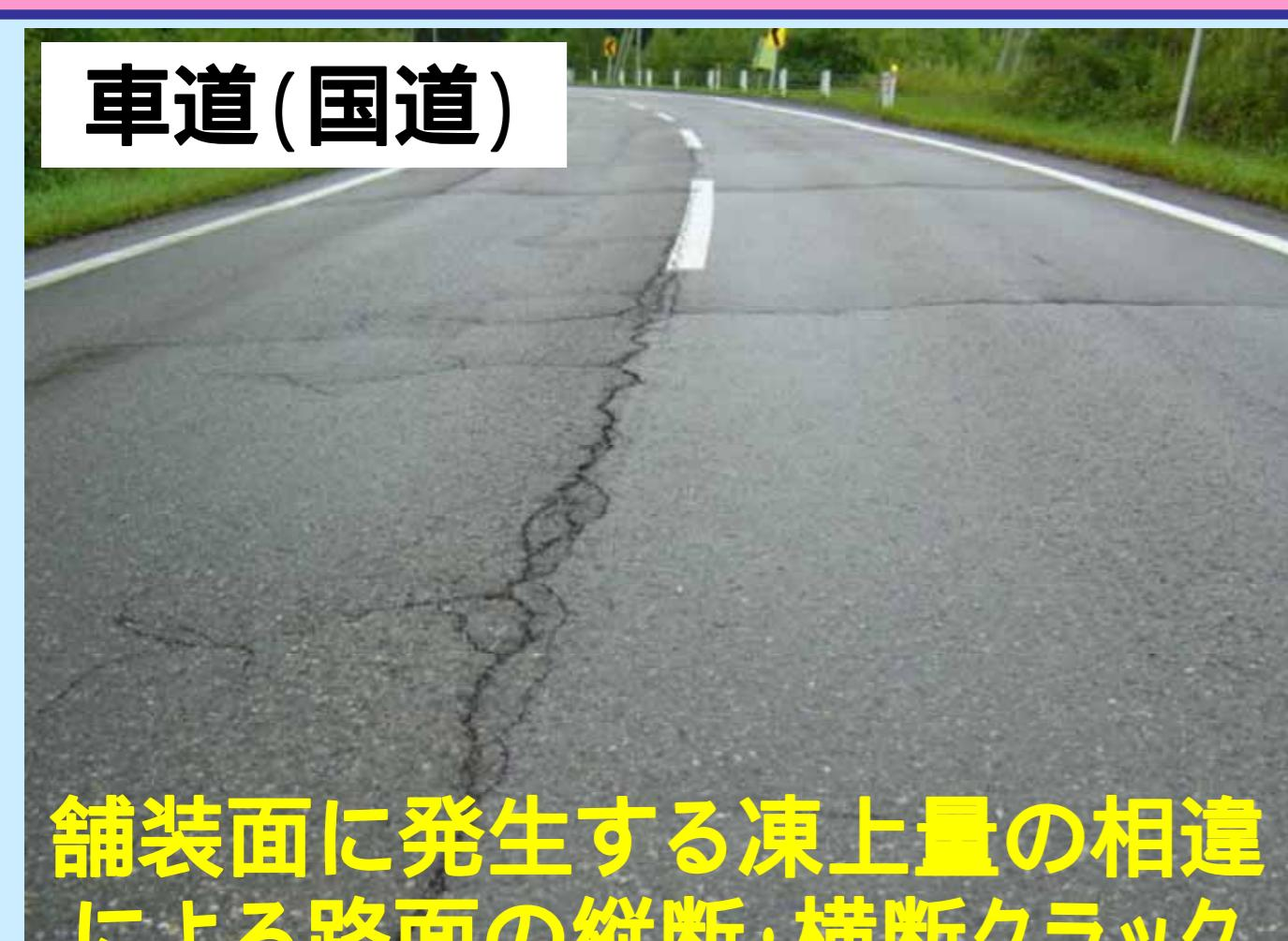
舗装面に発生する凍上量の相違による路面の縦断・横断クラック
