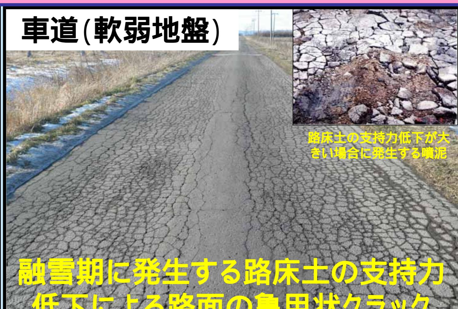
融雪期に発生する路床土の支持力低下による路面の亀甲状クラック
