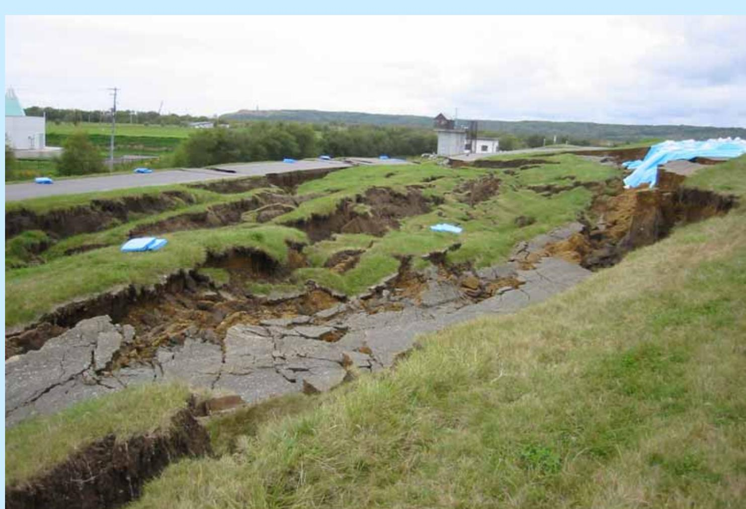
2003年十勝沖地震による河川堤防の被害。なお1993年釧路沖地震で被災した堤防で、強化復旧が行われた堤防は、この地震で被害は生じなかった。
