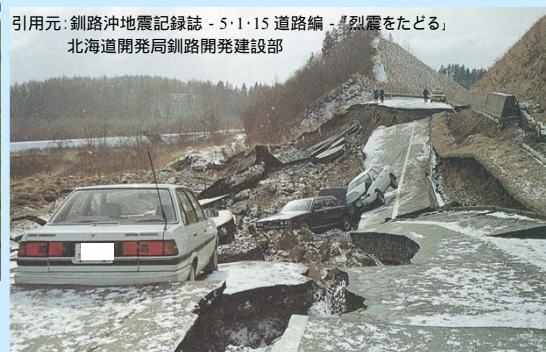
引用元:釧路沖地震記録誌 - 5・1・15 道路編 - 烈震をたどる 北海道開発局釧路開発建設部 1993年釧路沖地震による道路盛土の被害
