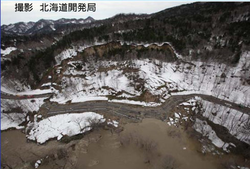
撮影 北海道開発局 国道239号(霧立峠):平成24年4月に発生した地すべりの様子。
