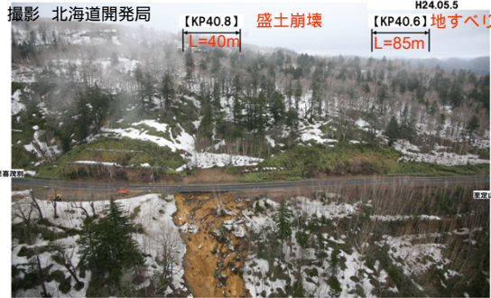
撮影 北海道開発局 国道230号(中山峠):平成24年5月に発生した盛土崩壊等の様子。
