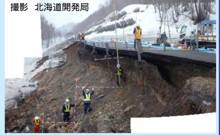
撮影 北海道開発局 国道230号(中山峠):平成25年4月に発生した盛土崩壊の様子
