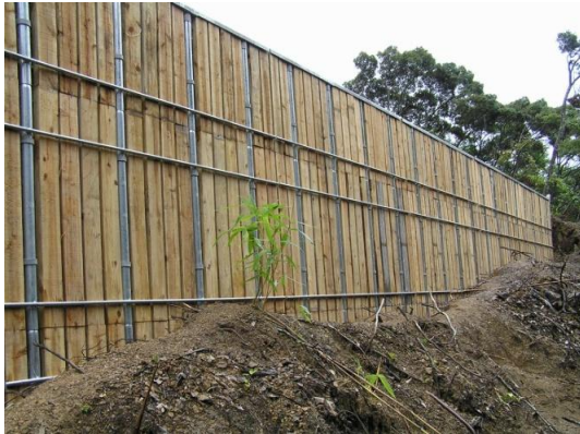
写真-13 木材仕様チェーンウォール工法
