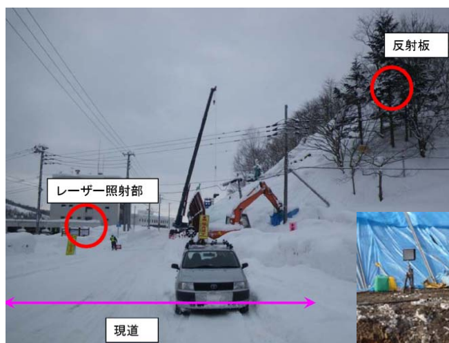
写真-4 拡散レーザ変位計計測斜面全景 (右下：反射板小段設置状況)
