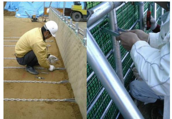
写真-6 フレックスジョイント取付け状況
