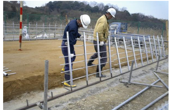
写真-5 パイプフレーム設置状況
