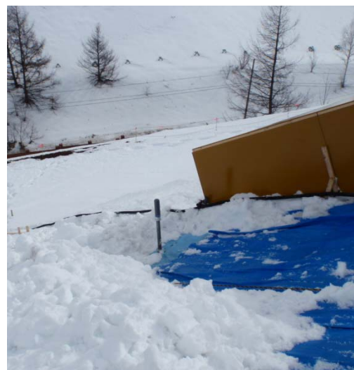
写真-5 Area net 傾斜計設置状況
