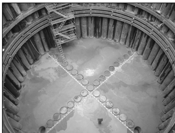
写真-5 鋼管矢板 掘削完了状況
