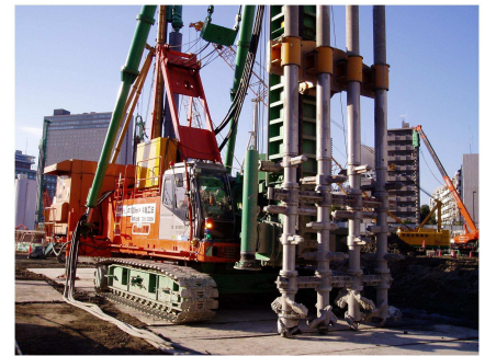
写真-1 4 軸施工機械
