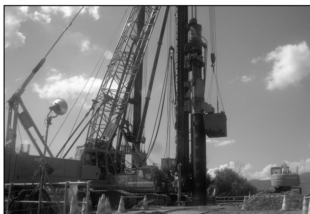
写真-4 鋼管の中掘り・圧入状況
