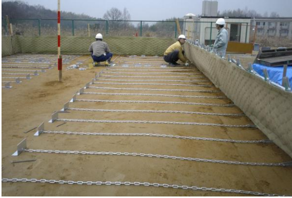
写真-7 チェーン敷設状況
