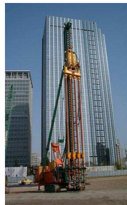
図-1 施工機械全景と液状化対策工のイメージ
