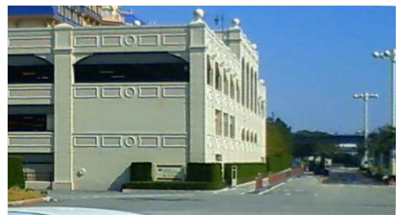
写真-5 対象建物の地震直後の状況
