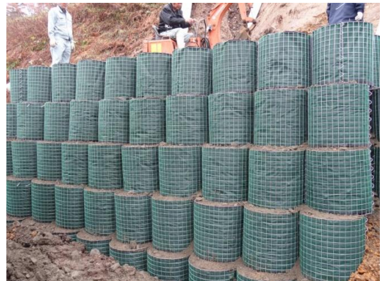
写真-14 フォレストウォール工法（円筒金網）
