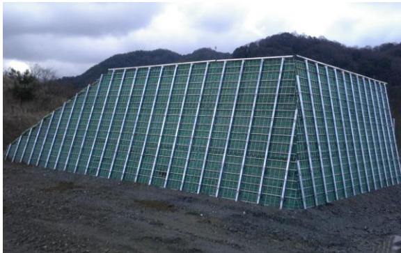
写真-9 補強土壁完成後の外観
