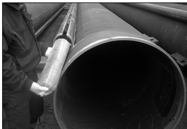
写真-3 充填材の設置
