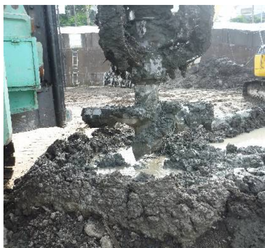
写真-1 杭破碎施工後の攪拌翼
