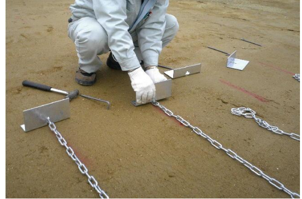
写真-8 支圧板取付け状況
