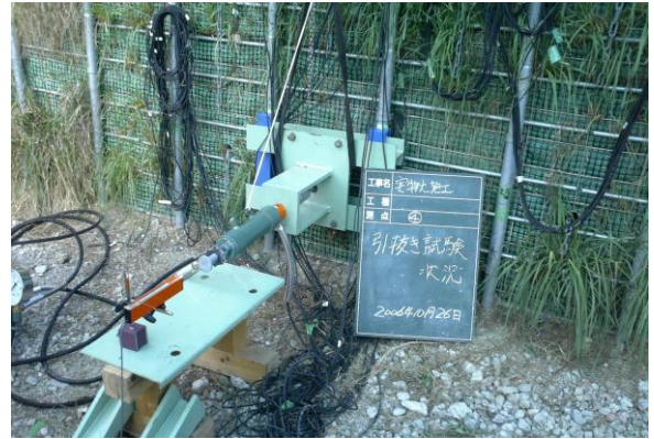
写真-12 引抜き試験状況
