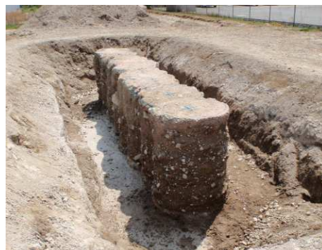
写真-8 2軸試験施工による改良杭
