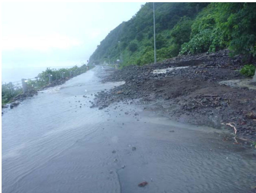
写真 2-2 集中豪雨に伴う土砂流出の事例（石狩市）
