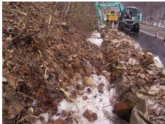
写真 3-6 クリアランス埋没例 (千歳市)
