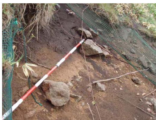
写真 3-8 応急対策工の破損例（せたな町）
