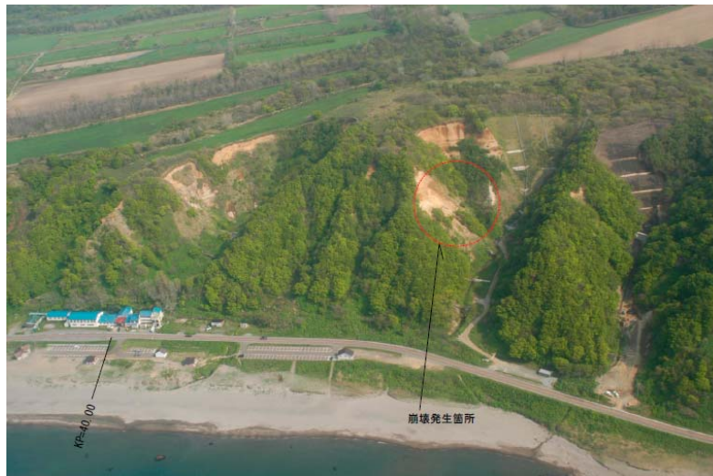
写真 2-1 融雪期の降雨による崩壊例（積丹町）
