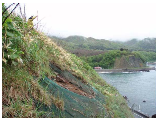
写真 3-8 応急対策工の破損例（せたな町）
