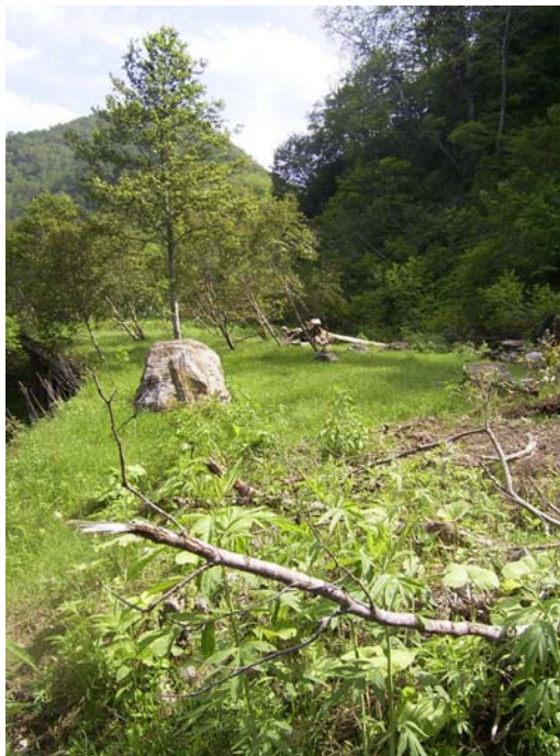
写真 3-9 覆道上で発見された落石〔φ2m〕（羅臼町覆道上の例）
