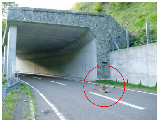
写真 1-2 転石型（抜落ち型）落石の発生源と被災例（羅臼）
