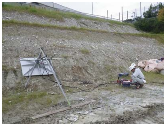
写真 6 極限引抜き試験状況
