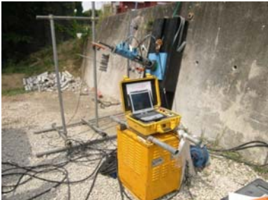
写真 4 引抜き試験状況
