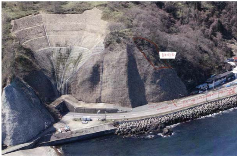
写真 1-1 法面と自然斜面の境界付近から落石が発生した事例（函館市古部町）
