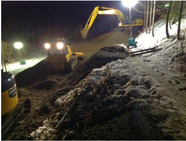
写真 4-3 押え盛土の施工状況
