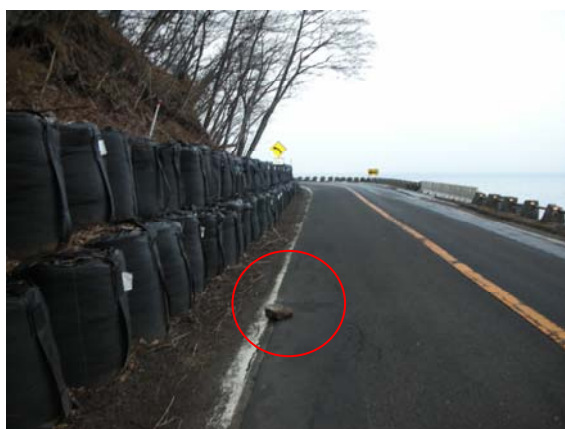
写真 3-3 大型土のうを超えて現道に到達した例（千歳市）
