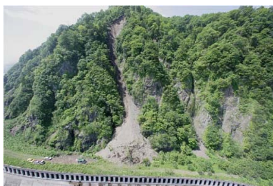
写真 3-7 覆道上部の崩壊事例（広尾町）
