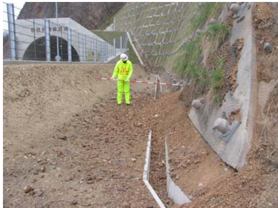
写真 3-17 表層保護工周囲からの崩壊例（石狩市）
