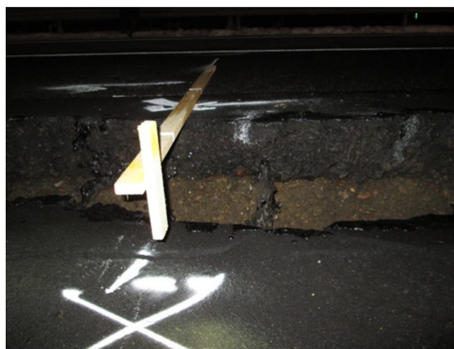
写真 4-2 舗装着手前の状況（段差高さ 22cm）
