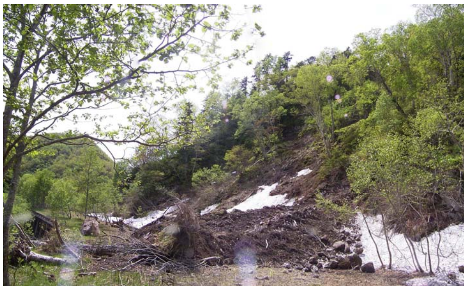
写真 3-15 覆道上に到達した土砂の例 （この場合は、残雪の上をオーバーフローして覆道上に到達：羅臼町）
