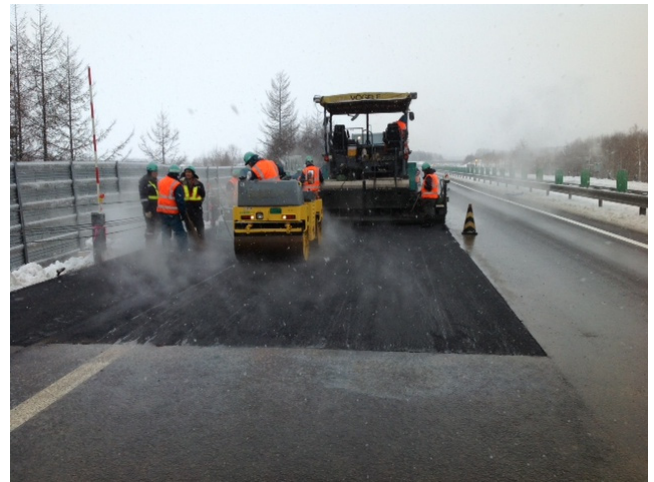
写真 4-4 舗装工事の施工状況
