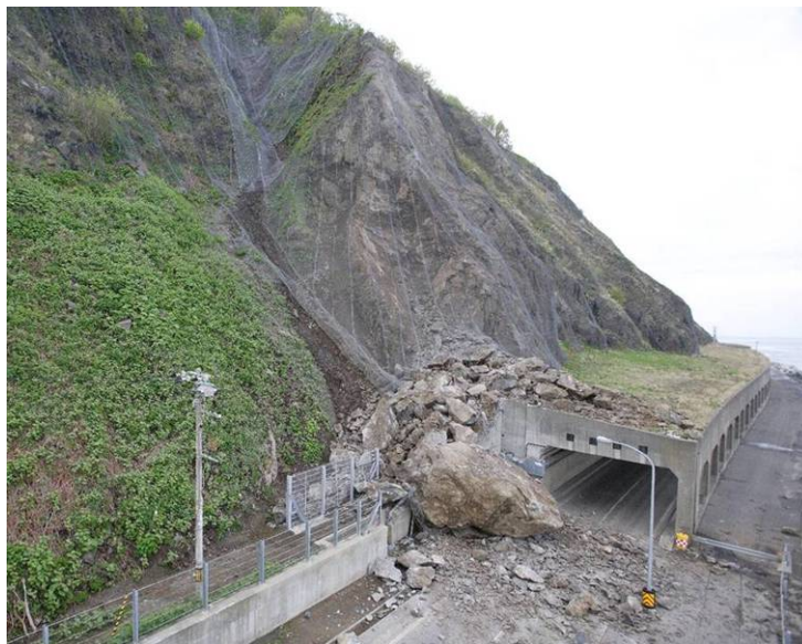
写真 3-1 尾根先端部の崩壊事例（増毛町）
