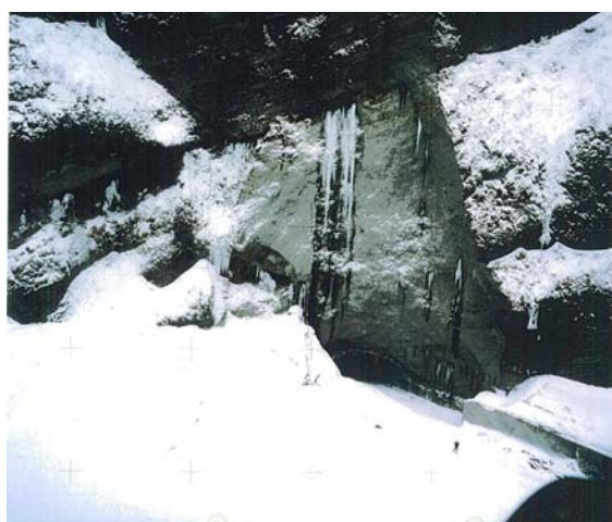
写真 3-6 崩落壁面の氷柱例（古平町）
