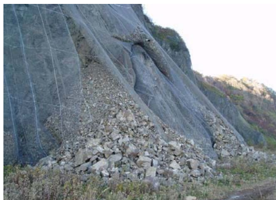
写真 2-1 地震による崩壊例（広尾町）
