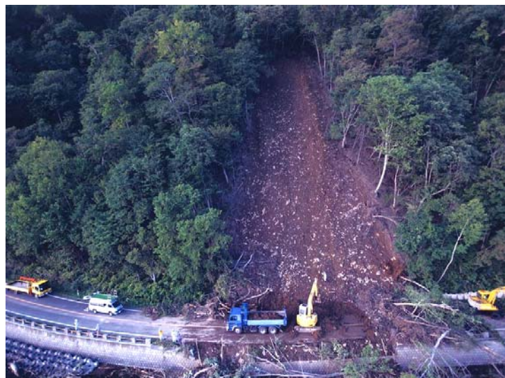
写真 3-12 風倒木被害の影響による崩壊発生例（千歳市）
