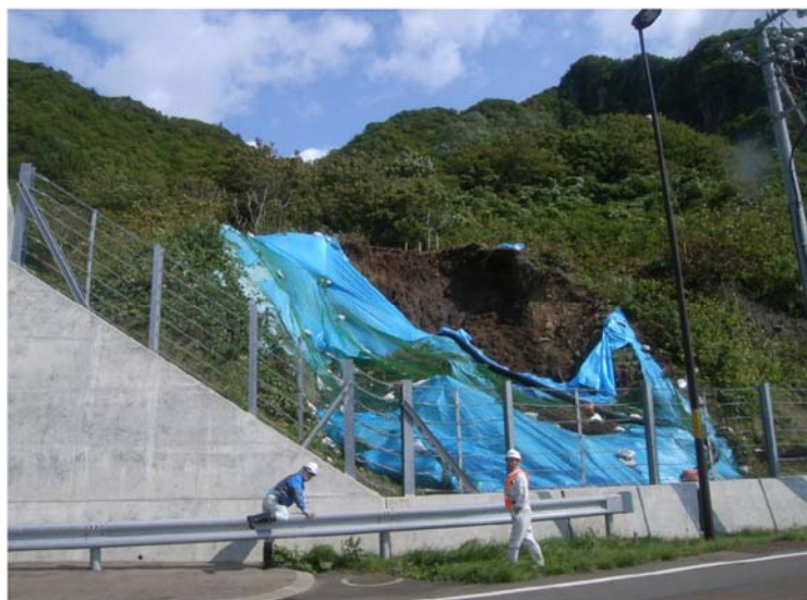
写真 3-3 応急対策箇所の崩壊例（神恵内村）
