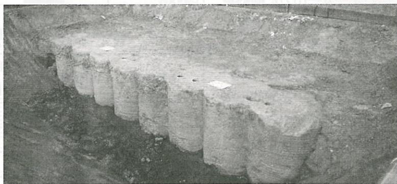
写真5 改良体の掘り出し状況
