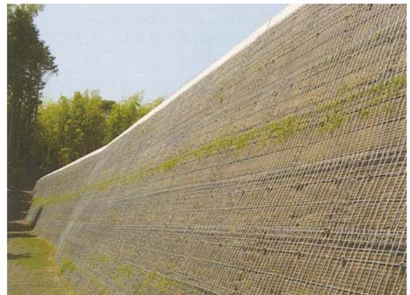
写真 5 鋼製枠形式の壁面
