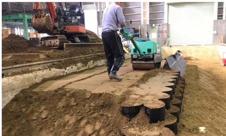
写真10 テラグリッド壁面裏の締固め (ハンドガイドローラー)
