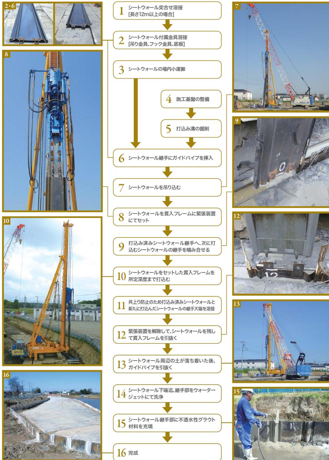
図-7 施工手順<sup>1)</sup>
