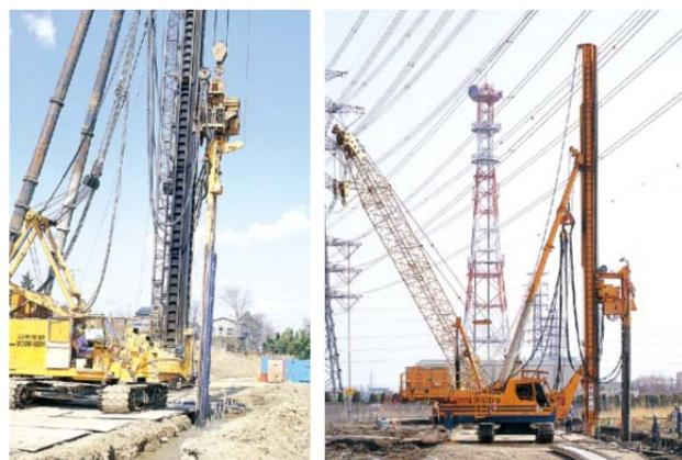
写真-1 バイブロ式打込み機 写真-2 圧入式打込み機
