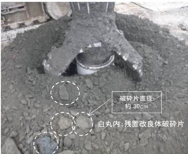
写真-2 残置改良体の破碎状況
