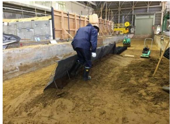
写真9 鋼製枠裏の締固め
