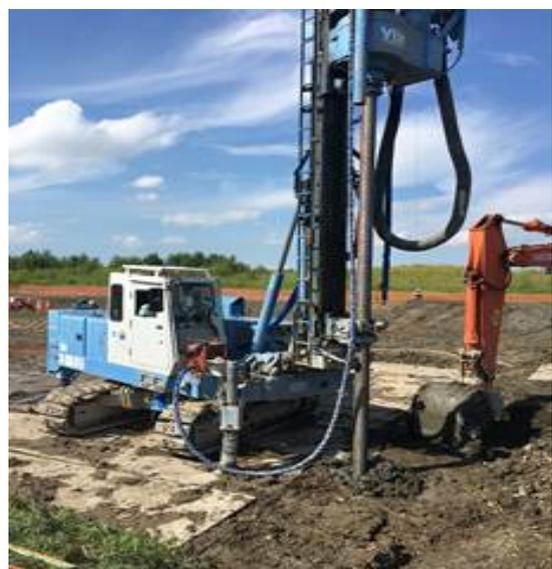
写真-2 LDis工法・GIコラム兼用機
