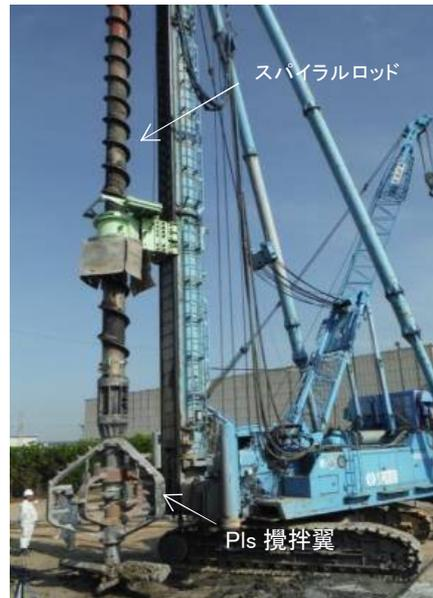
写真-3 Pls 工法(スパイラルロッド式)による試験施工全景
