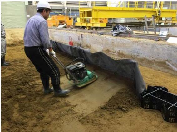
写真8 鋼製枠裏の締固め
