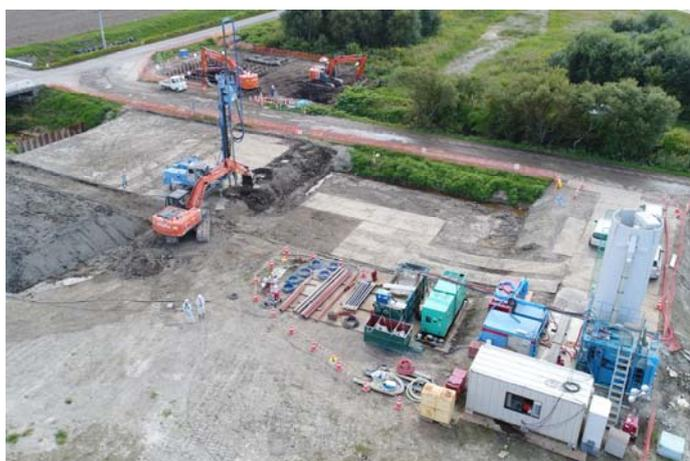
写真-3 GIコラム施工状況及びプラント全景
