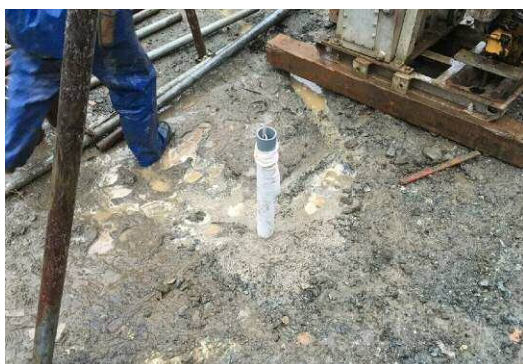
写真-1 パイプ傾斜計とロガー設置状況
