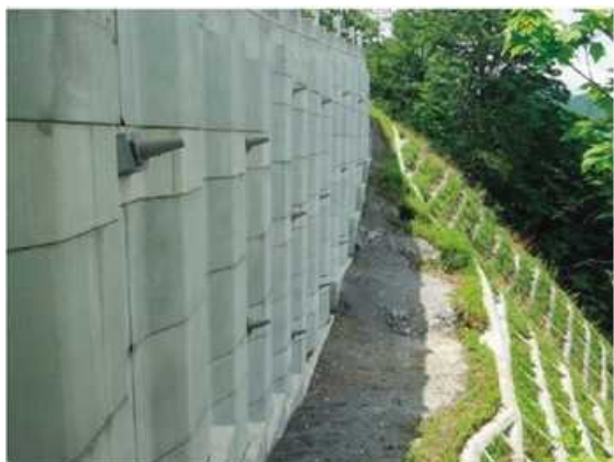
写真-10 オーレン親杭パネル壁の状況
