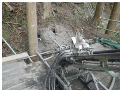
③反力体設置工(削孔工)
