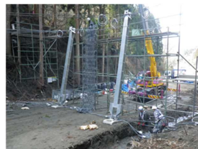
⑥本体組立工(ネット)
