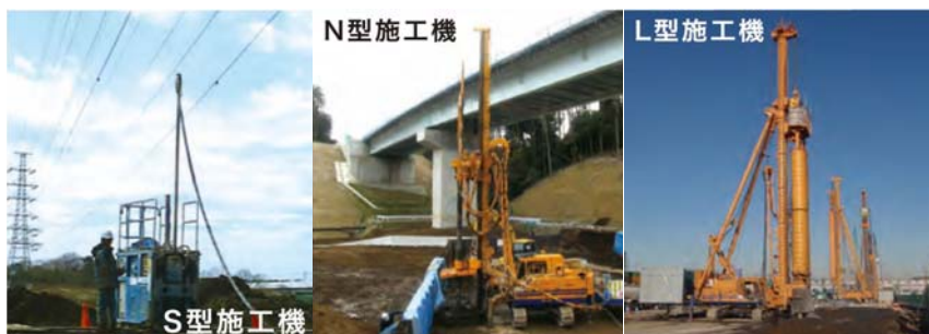
写真-8 施工機械
