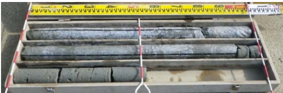
写真 1 コアボーリングした改良体(適用例 1)
