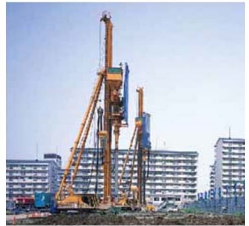
写真-2 市街地での施工状況 (静的締固め砂杭工法)
