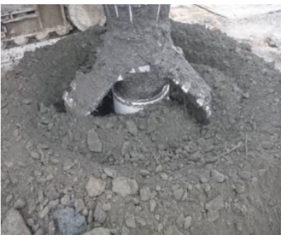
(b)既設改良固化盤破碎施工
