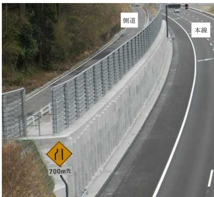
写真-5 落石防護柵併用事例
