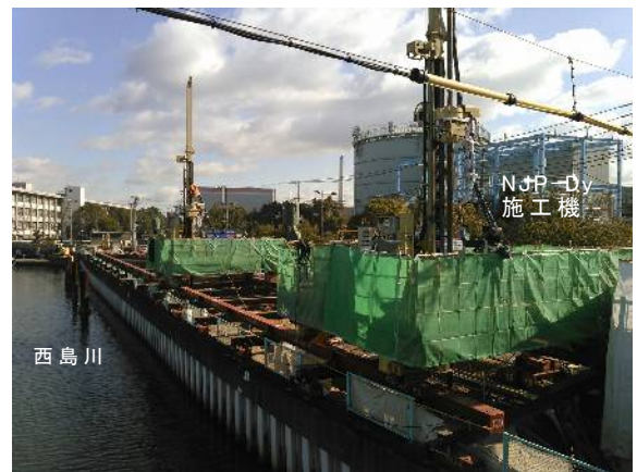
写真－５ 西島川護岸部施工状況
