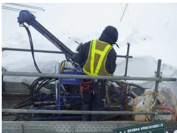
写真-11 削孔
