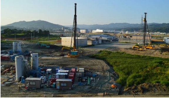
写真-3 SDM-Fit-IV施工全景
