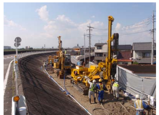
写真-4 堤防法面上での施工状況 (砂圧入式静的締固め工法)
