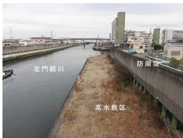
写真－2 既設防潮堤状況
