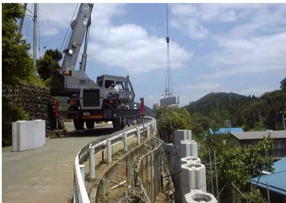
写真-2 老朽化した既設擁壁の補強事例
