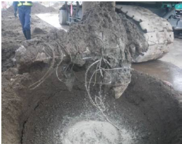
写真-3 Taf 先端ヘッドへの鉄筋巻付き状況
