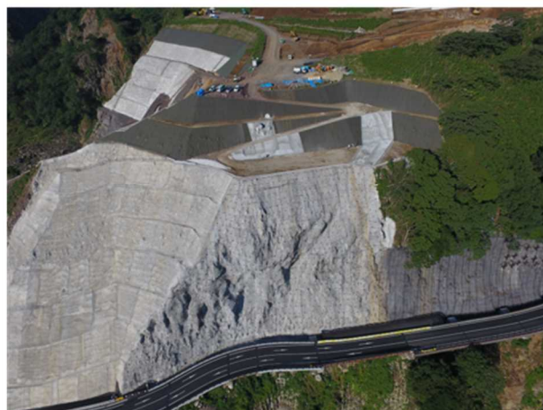
写真-16 高強度ネット工法施工事例
