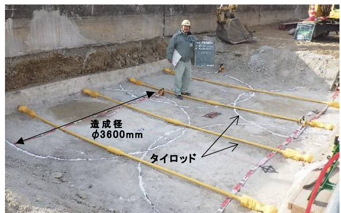
写真－6 改良体出来形
