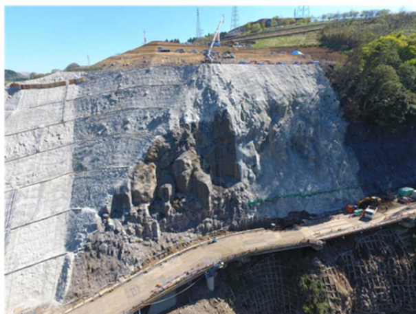
写真-16 高強度ネット工法施工事例
