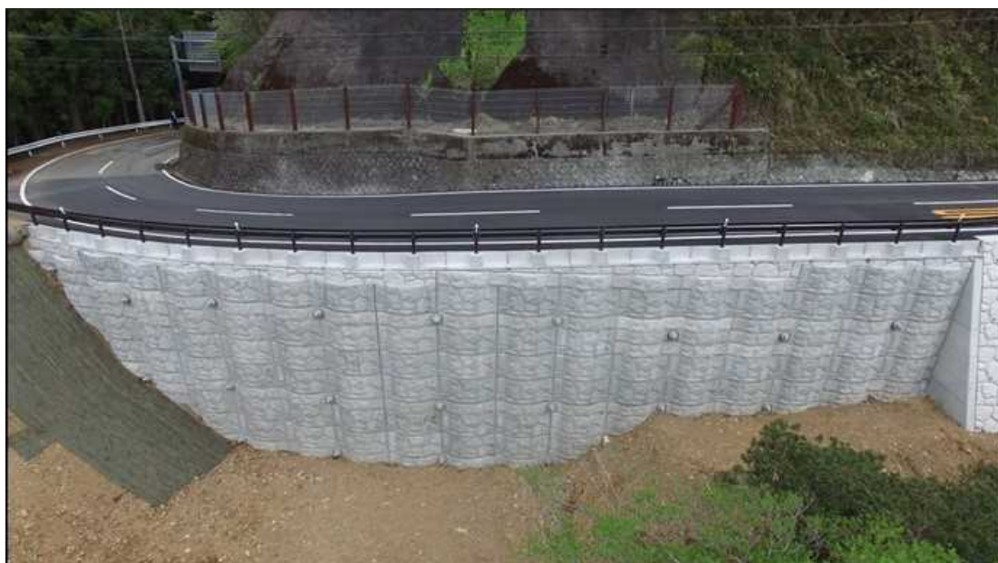
写真-7 化粧型枠使用事例
