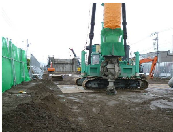
写真-5 エポコラム Taf 施工状況
