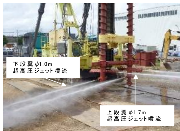
写真-1 SDM-Fit-IV 工法施工機全景と水噴射状況
