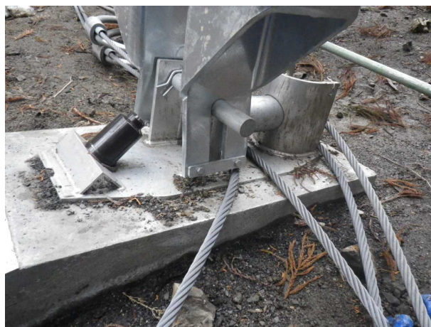
写真-2 支柱基部
