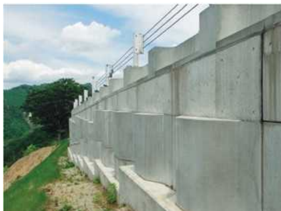
写真-11 鳥帽子親杭パネルの状況
