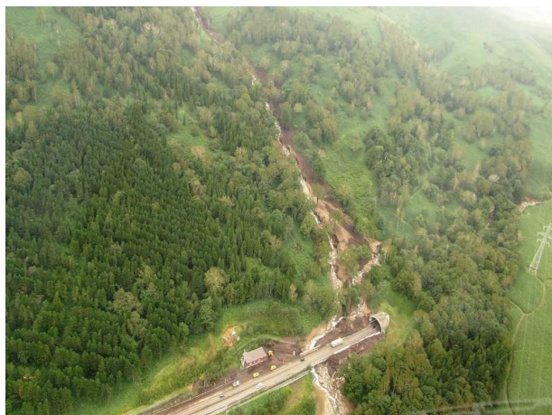
写真-9 被災状況
