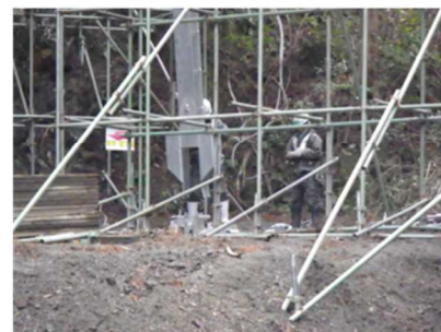
⑥本体組立工(支柱)
