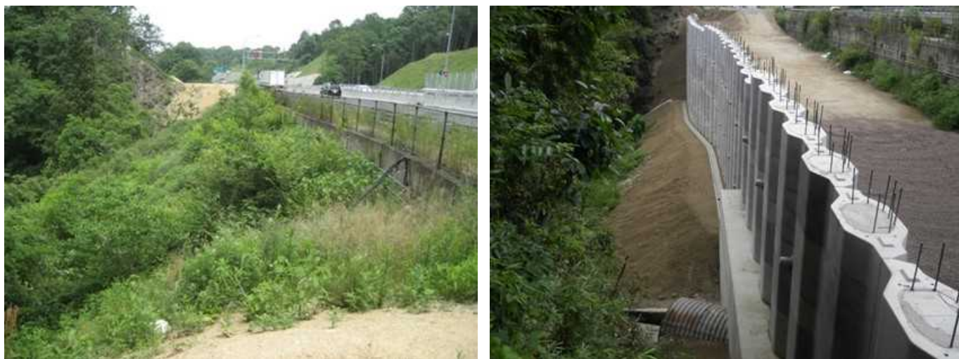
写真-1 道路の拡幅事例
