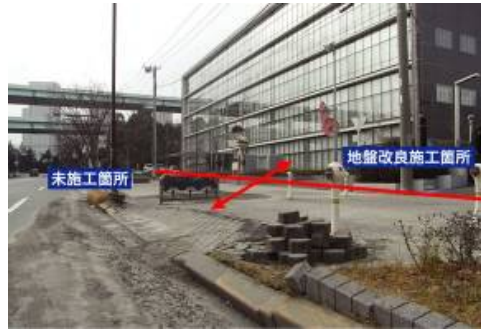
写真-1 地震後の建築物の状況 (東北地方太平洋沖地震)
