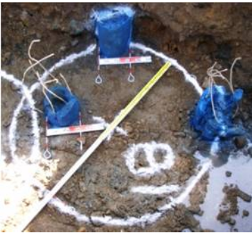
(a)PC 杭破碎同時施工
