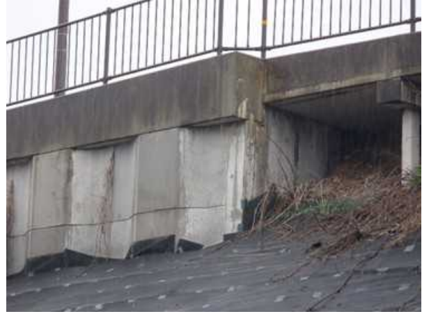
写真-13 世安地区電線共同溝での状況（拡大）
