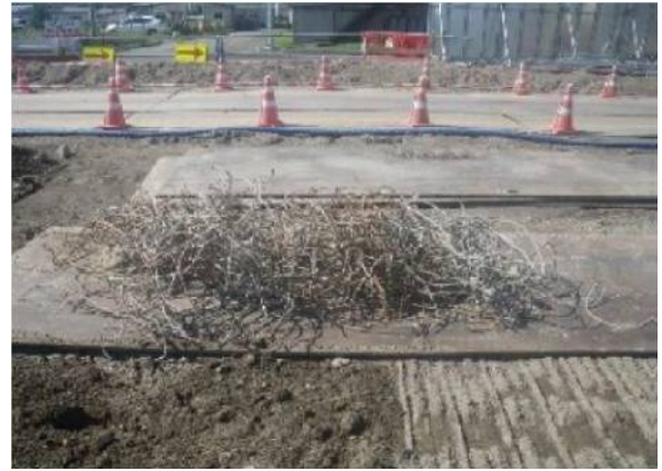
写真-4 巻き付きした鉄筋の回収状況
