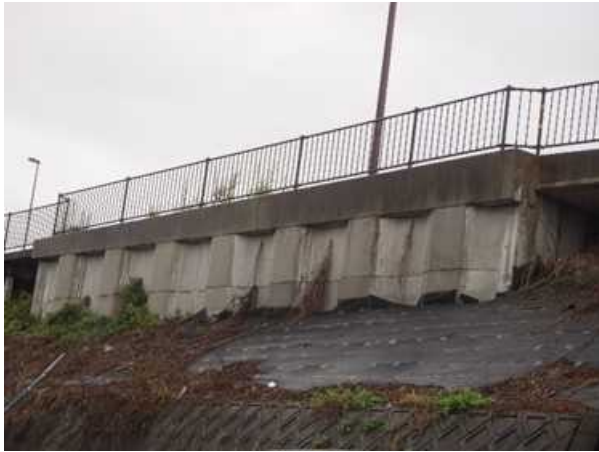
写真-12 世安地区電線共同溝での状況
