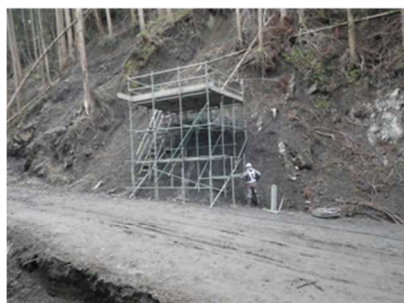
②仮設工(足場工)
