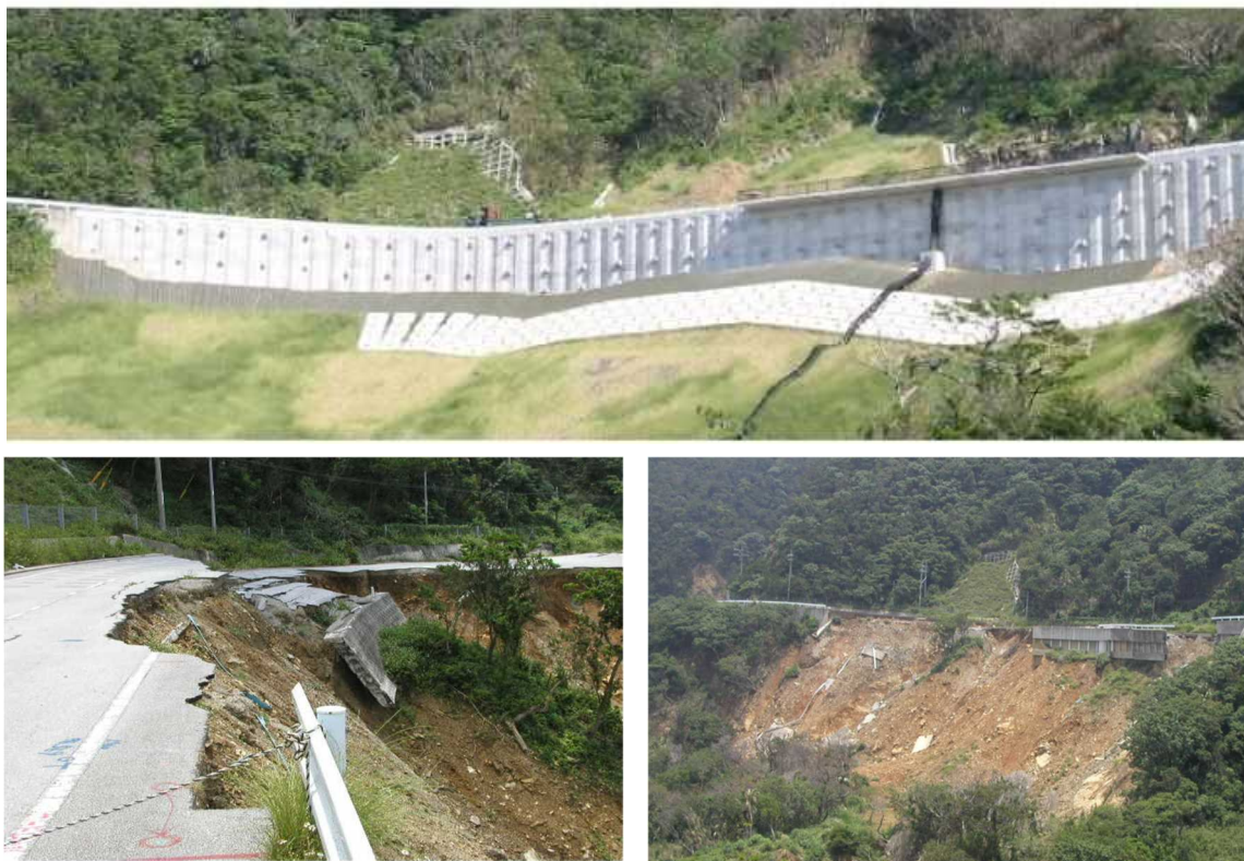
写真-3 台風災害の復旧事例
