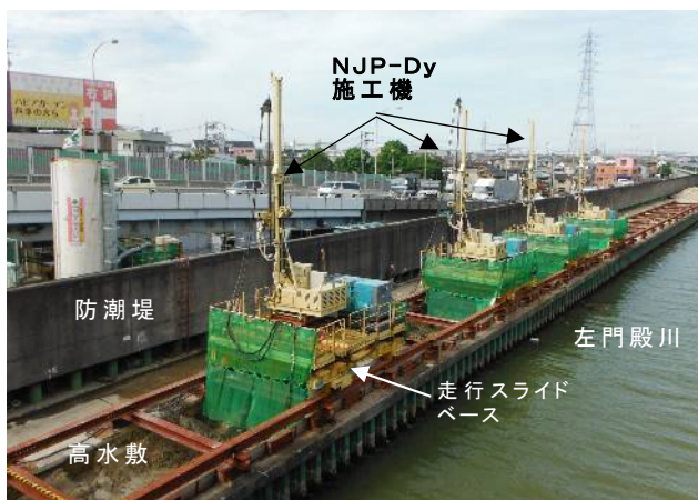
写真－3 左門殿川護岸の施工状況
