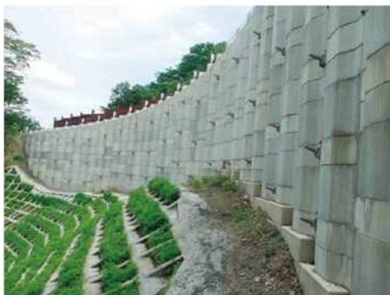
写真-8 茂庭沢親杭パネル壁の状況
