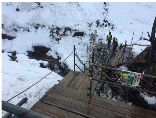
写真-10 足場組立
