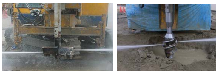
写真-7 改良材スラリー噴射状況
