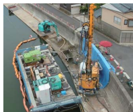
写真-9 施工状況
