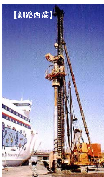
写真-8 グラベルドレーン施工状況
