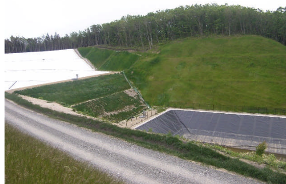
写真-7 施工後1年経過状況
