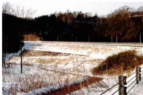
写真-6 道路盛土（対策箇所）
