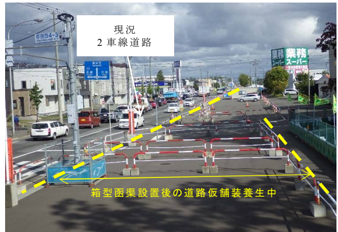
写真-5 箱型函渠設置の完了後道路整備前 (令和元年 9 月現在)
