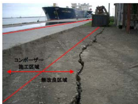
第 3 埠頭-7.5m 岸壁(写真 A)
