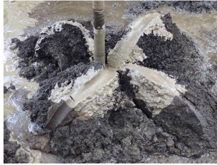
写真-2(b) 泥炭性地盤の LDis-Dy 排土状況(改良終了時点) (平成 31 年度施工)
