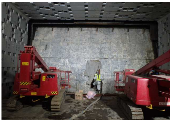
写真－１ 施工箇所全景
