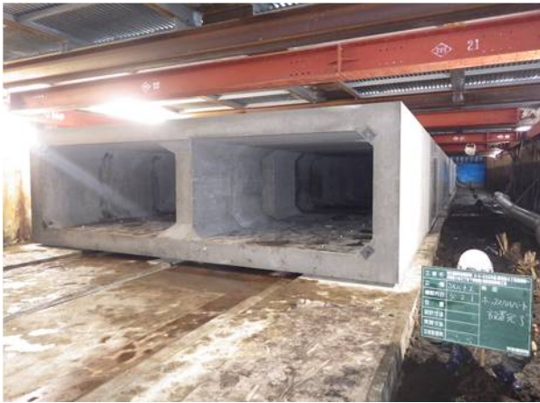
写真-4 2) 箱型函渠を設置した状況 (平成 29 年度施工)
