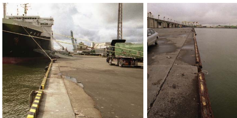
第 1 埠頭-12m 岸壁
