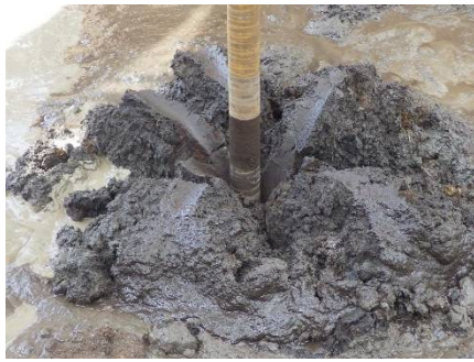
写真-2(a) 泥炭性地盤の LDis-Dy 排土状況(改良途中時点) (平成 31 年度施工)
