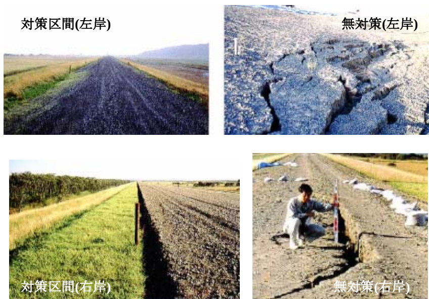
写真-14 地震後の状況（釧路川遊水地築堤）
