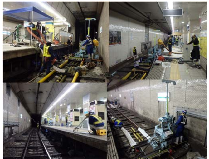
写真2 改良型施工機による施工状況
