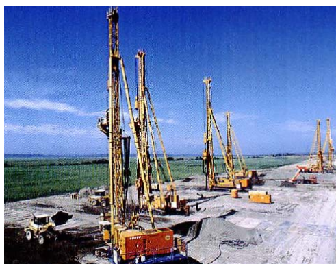
写真-13 SCP 施工状況（釧路川遊水地築堤）
