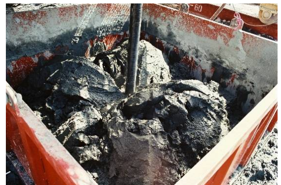
写真-6 LDis-Dy 排土状況(粘性土の場合)
