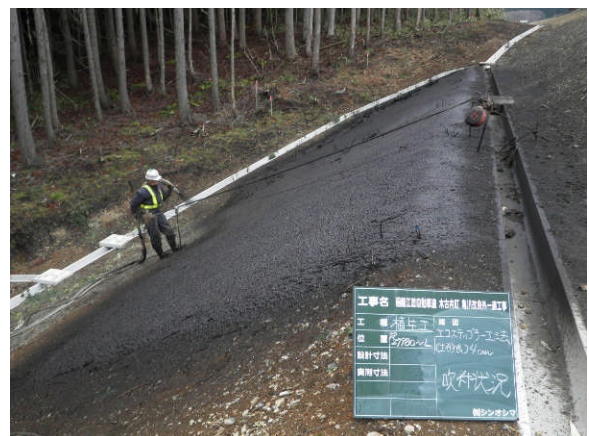
写真-5 吹付け状況
