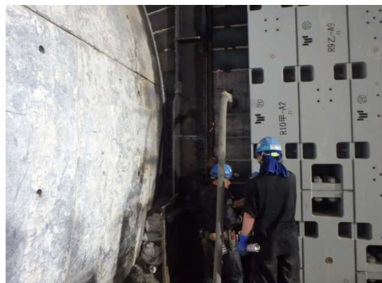
写真－２ 注入状況
