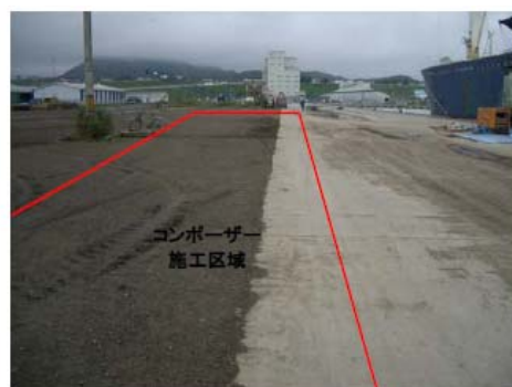
第 3 埠頭-10m 岸壁(写真 B)
