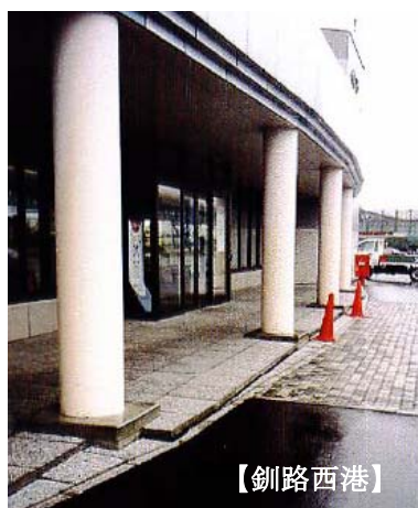
写真-11 北海道東方沖地震 （無対策箇所）
