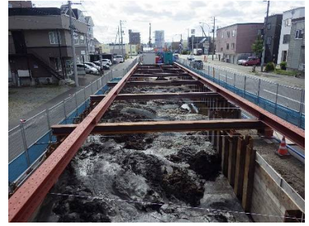
写真-2(c) 泥炭性地盤の LDis-Dy 排土状況(施工終了時) (平成 31 年度施工)
