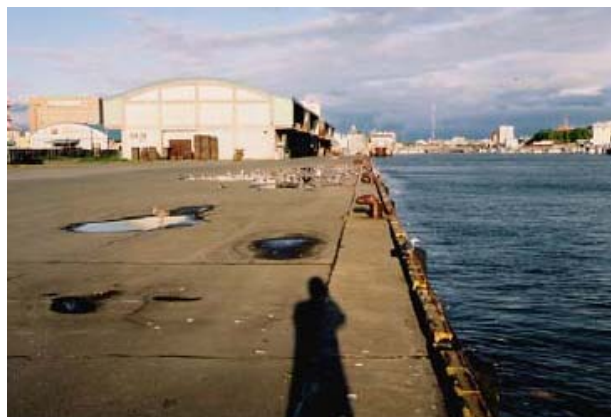
写真-17 釧路東港（対策箇所）
