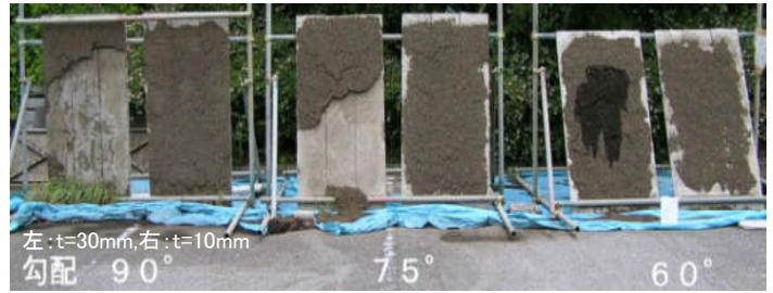
写真-3 吹付け後 1 年経過後状況
