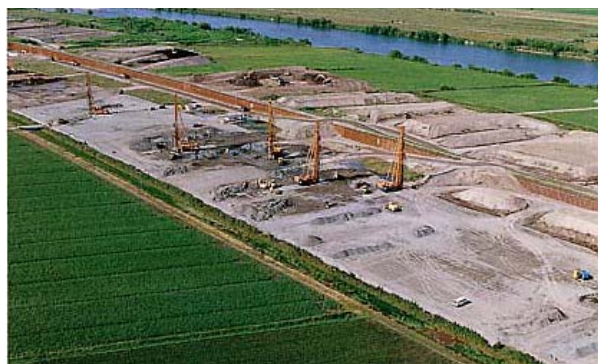
写真-19 SCP 工法施工状況
