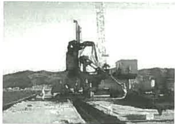
図8 鉛直遮水工施工状況
