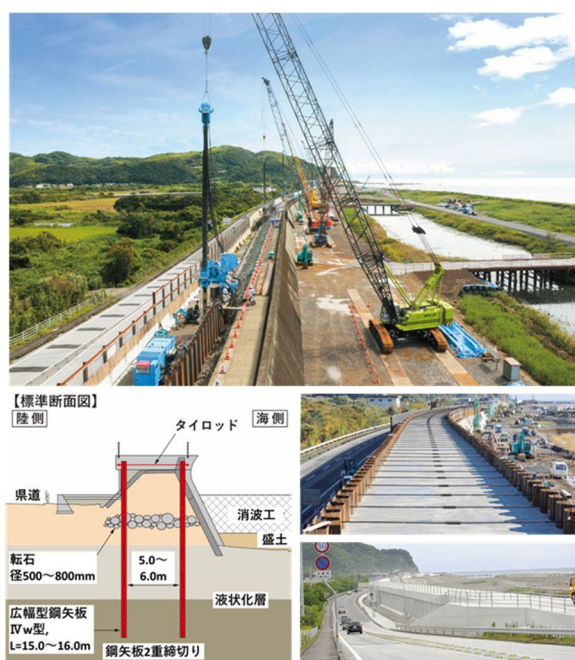
図-9 仁ノ海岸堤防改良工事
