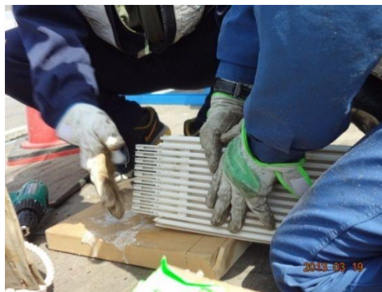
写真-6 ストリップジョイナー接続状況
