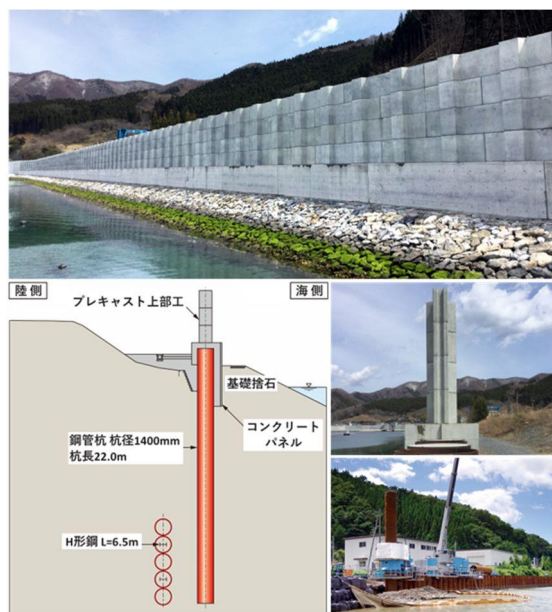
図-15 プレキャスト上部工の事例 大船渡港長浜地区海岸防潮堤工事
