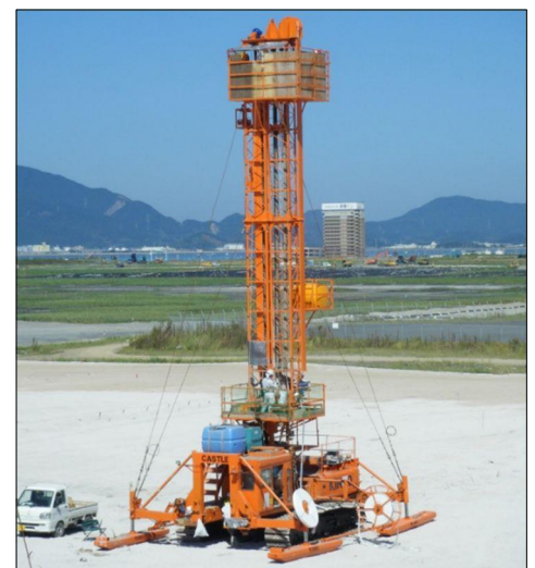
写真-2-1 継杭打設式ドレーン施工
