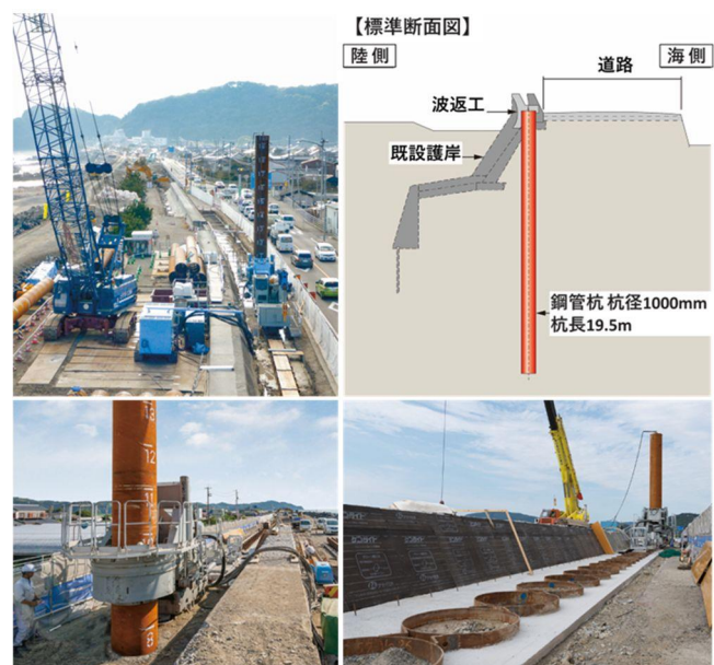
図-10 新居海岸堤防改良工事
