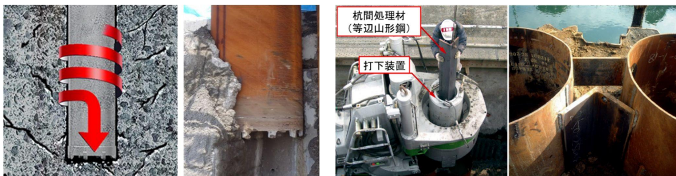
図-5 回転切削圧入（ジャイロプレス工法）
