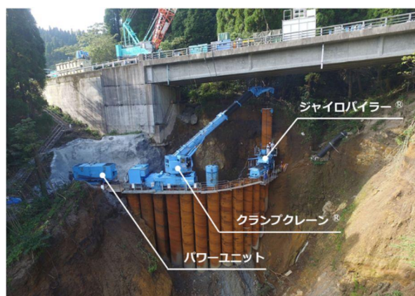
図-20 鋼管杭の施工状況
