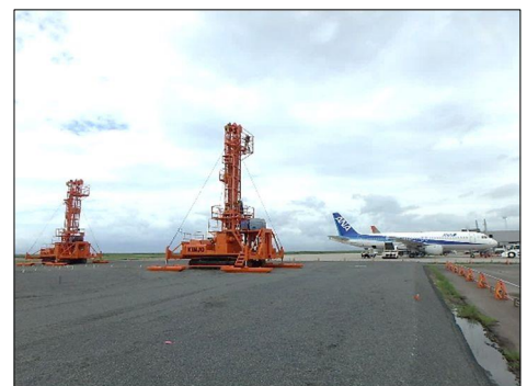
写真-3-1 施工状況
