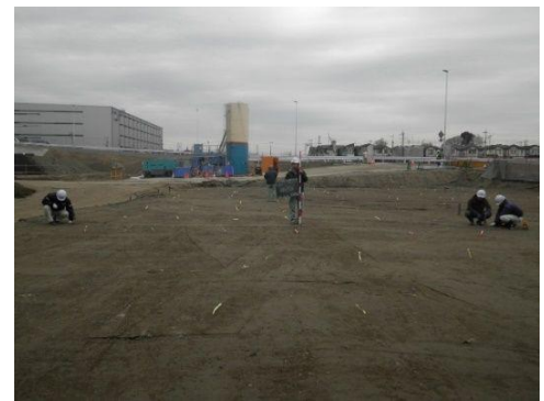
写真-3.1 打設位置確認の立合い
