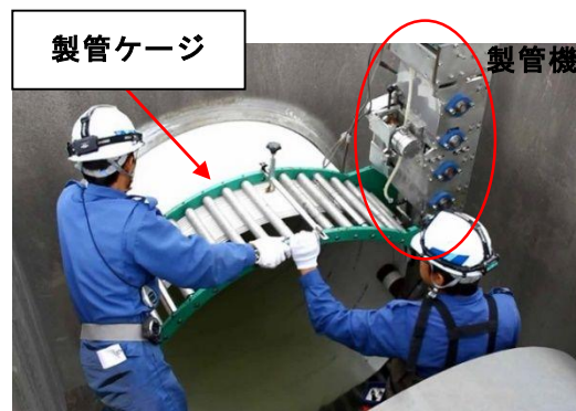
写真－1 製管状況
