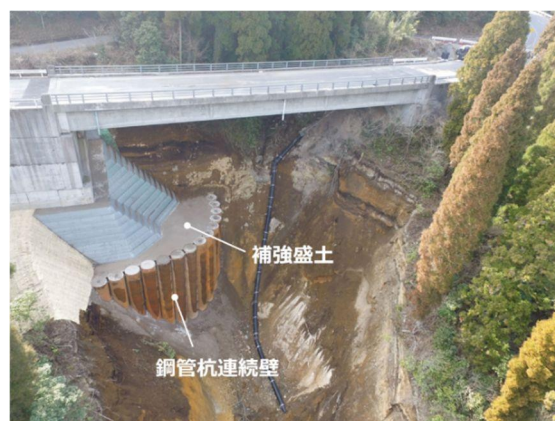
図-21 竣工時の状況
