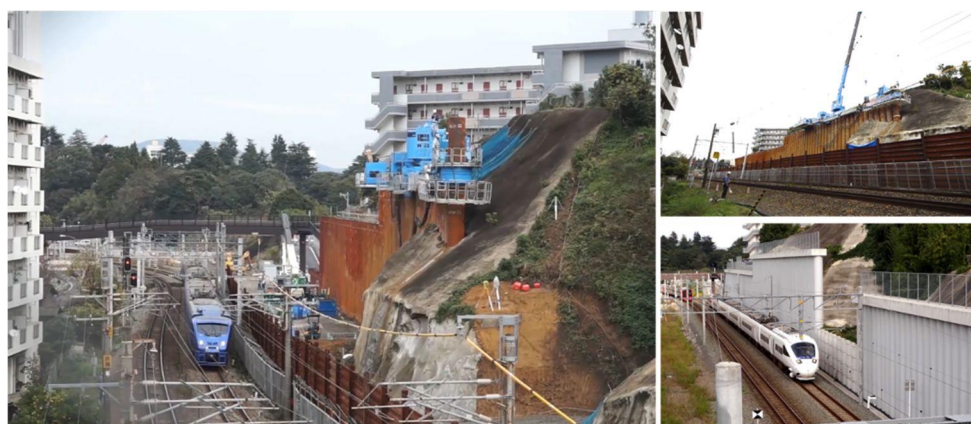
図-16 鉄道平面の線形変更に伴う線路用地の拡幅・擁壁築造 1) 改
