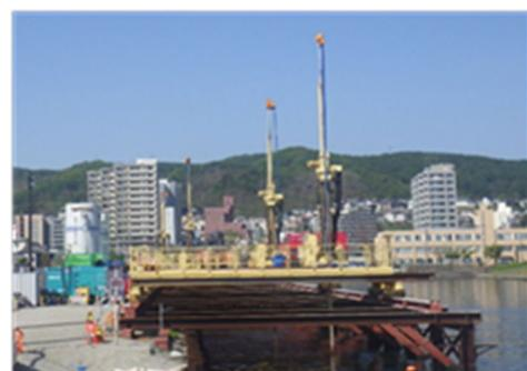
図-3.4 走行台車(スライドベース)上の施工機
