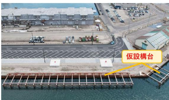
図-3.3 仮設構台の設置状況
