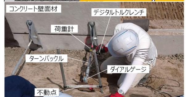
図-9 施工時の計測方法
