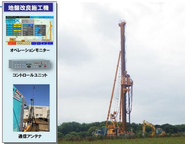
写真-5 本工事の施工状況 (CI-CMC-HA)
