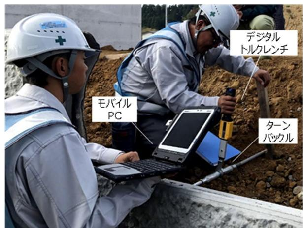
写真-5 施工で行ったトルク計測の様子
