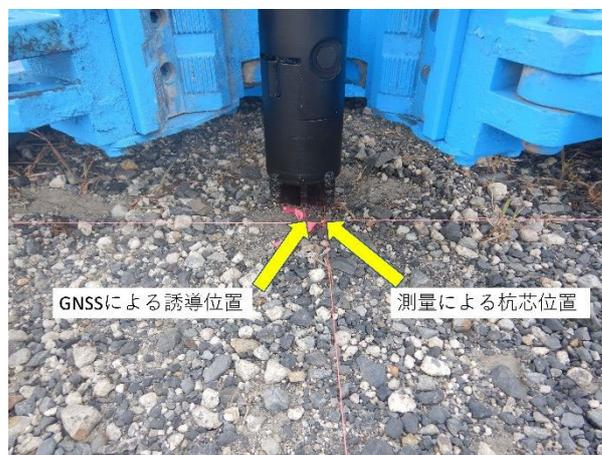
写真 2 誘導精度確認状況
