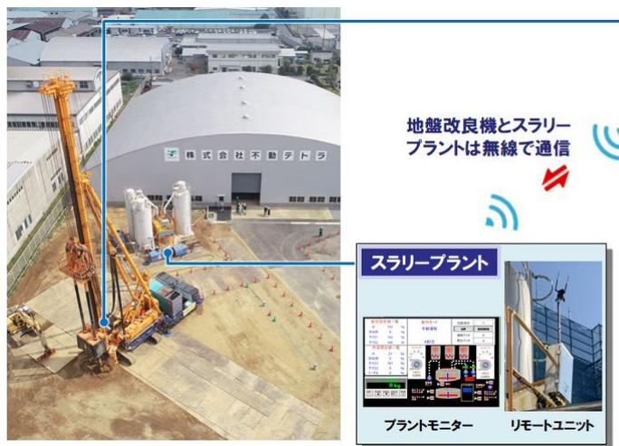
図-2 GeoPilot<sup>®</sup>-AutoPile のシステム概要
