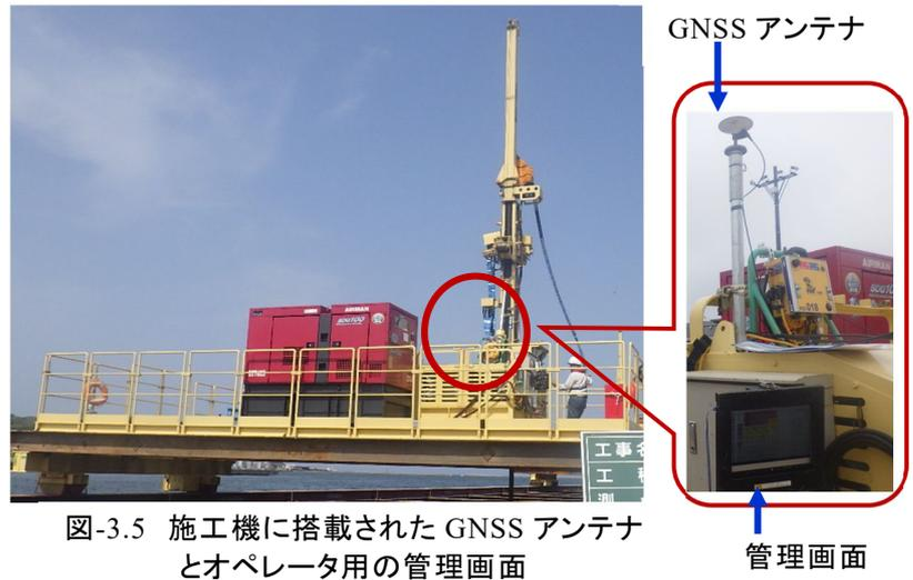
図-3.5 施工機に搭載された GNSS アンテナとオペレータ用の管理画面
