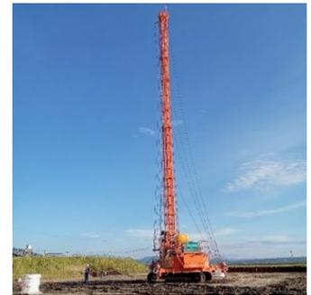
写真-3-2 ドレーン施工機
