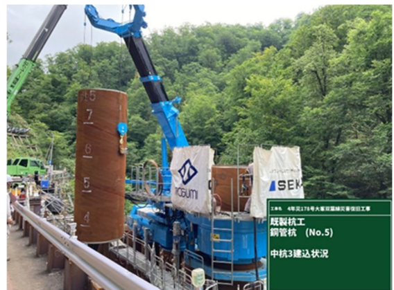
図-22 鋼管杭の施工状況
