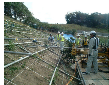
写真-13 プレ削孔による施工事例
