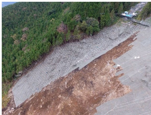
写真-5 高強度ネット工施工
