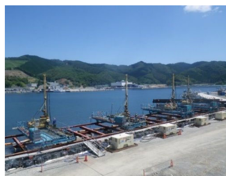
写真-6 岸壁補強施工状況
