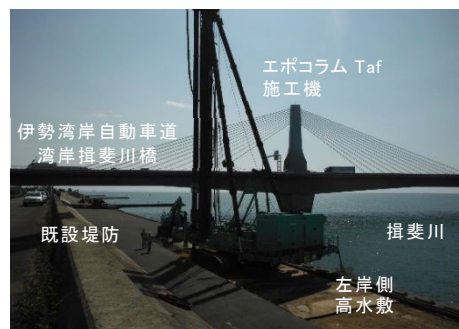
写真-4 エポコラム Taf 工法の施工状況
