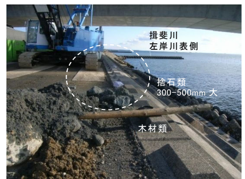
写真-5 掘り出された高水敷部の捨石, 木材類状況
