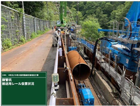
図-23 パイルランナー™を使用した現場内小運搬
