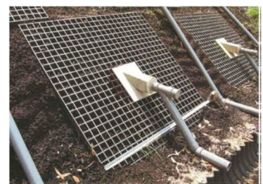
写真－16 表面に受圧板 を用いた事例
