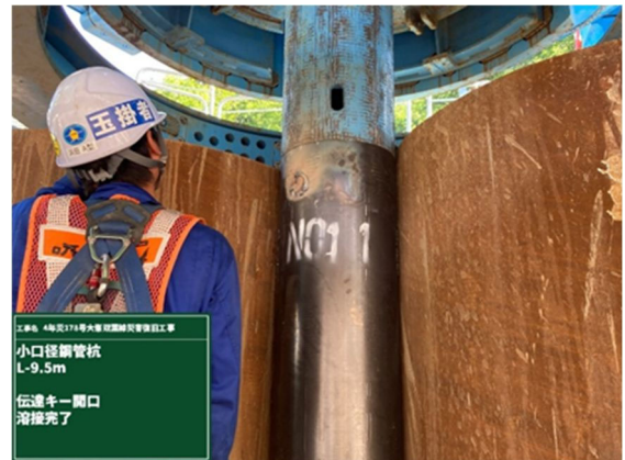
図-26 小口径鋼管の施工状況
