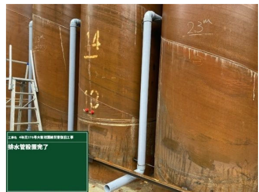
図-28 排水管の設置状況
