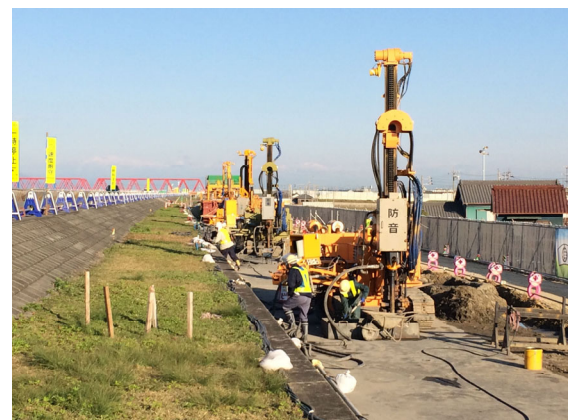
写真-4 SAVE-SP 工法
