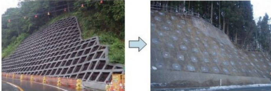
写真-1（左：従来技術の一例、右：高強度ネット工法）
