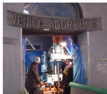
写真 1 小型施工機適用例 1
