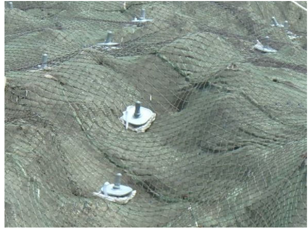
写真-8 補強材の施工状況
