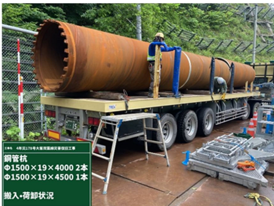
図-21 鋼管杭の搬入状況
