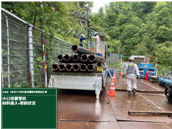
図-25 小口径鋼管の搬入
