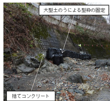
図-9 応急復旧（護岸部）
