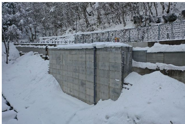
図-30 竣工後の自立山留め式擁壁
