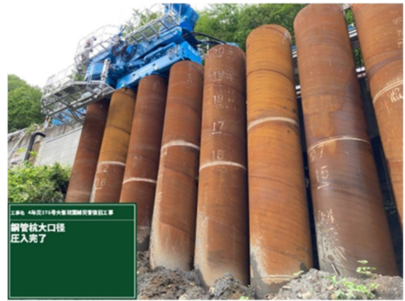
図-24 鋼管杭の設置状況
