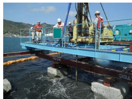
写真-7 簡易的なブロック積仮設状況
