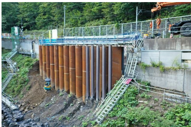
図-29 鋼管杭連続壁の施工完了時の状況
