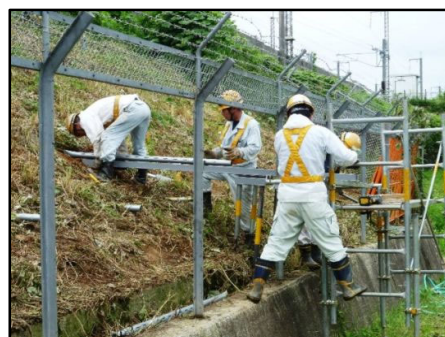
写真-2 排水補強パイプの打撃貫入
