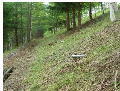
写真-5 道東自動車道の施工事例
