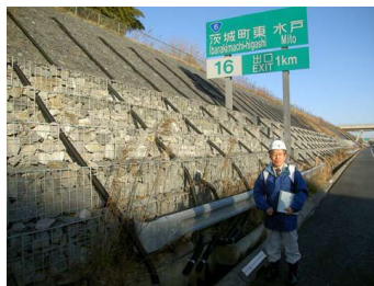
写真－15 縦溝に設置された 高密度ポリエチレン管
