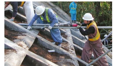
写真－4 排水補強パイプ打ち込み状況
