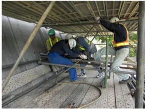
写真-7 擁壁の施工事例
