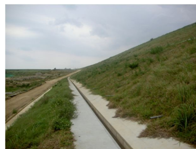
写真-17 多機能フィルターによる のり面保護工事例
