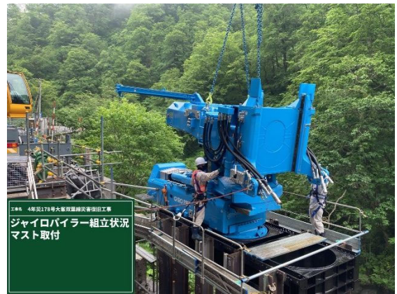
図-20 ジャイロパイラー™ 組立状況
