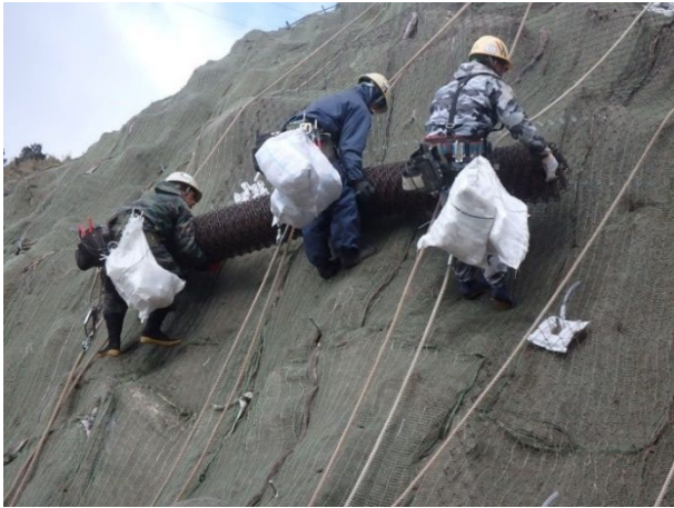
写真-7 ネット張り状況
