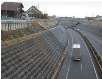
写真－14 完成後の切土斜面
