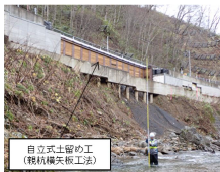
図-8 応急復旧（擁壁部）
