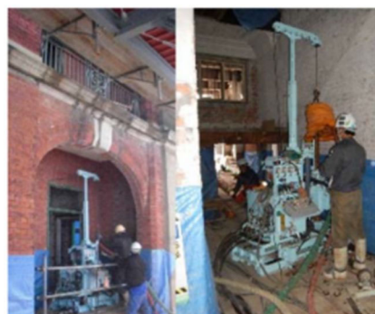
写真 2 小型施工機適用例 2
