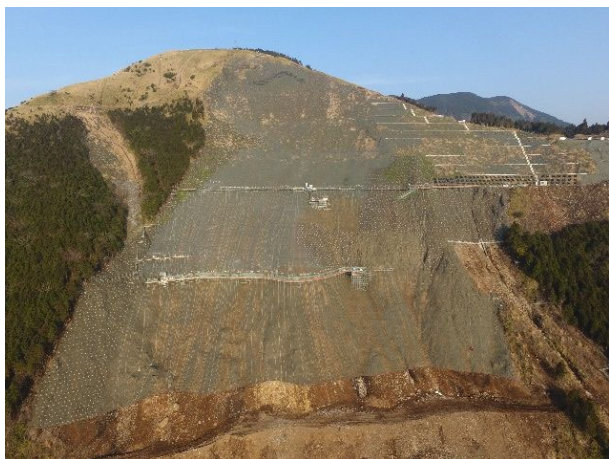
写真-4 施工時現場全景
