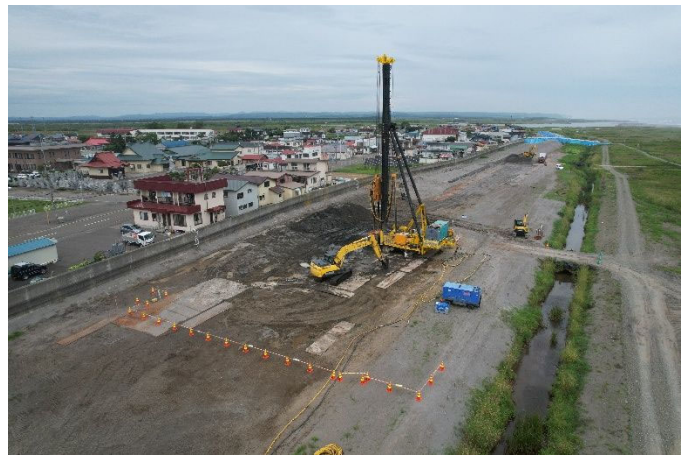
図-13 CI-CMC 工法 施工状況
