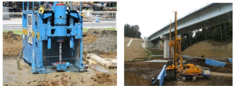
図-7 FTJ 工法 使用施工機械 (左図：FTJ-S 型、右図：FTJ-N 型)
