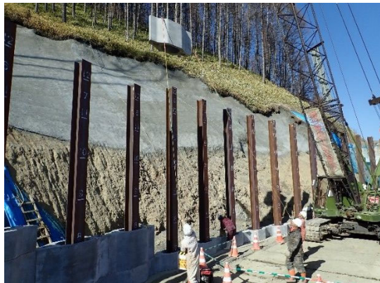
写真-1 親杭パネル壁設置状況
