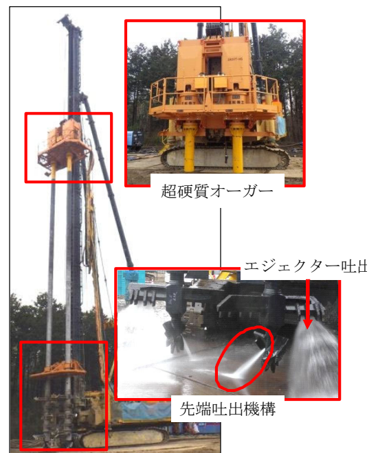
図-5 超硬質オーガーと先端吐出機構
