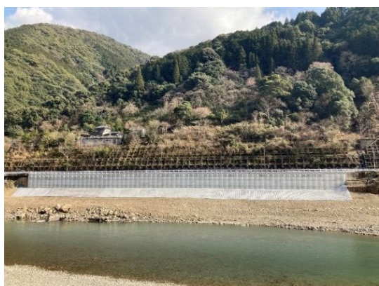
写真-6 親杭パネル壁工法復旧状況
