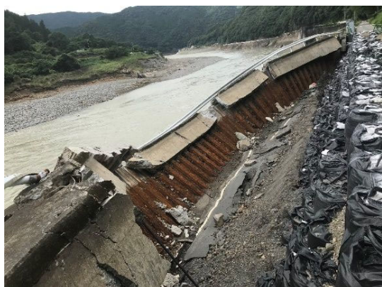
写真-4 鋼管杭＋鋼矢板擁壁の倒壊
