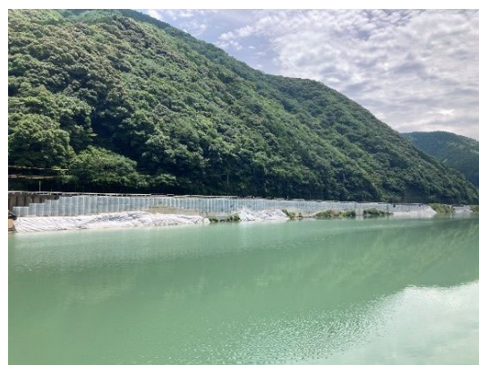
写真-7 親杭パネル壁工法復旧状況(伊高瀬地区)
