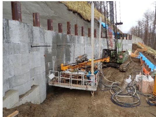
写真-2 アンカー工削孔状況
