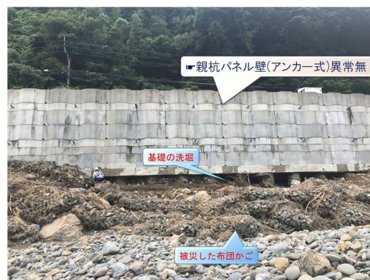
写真-5 親杭パネル壁の基礎洗掘状況
