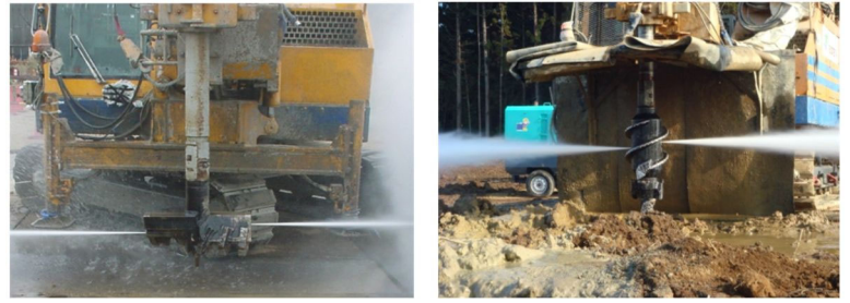
図-6 FTJ 工法 攪拌翼 (左図：一般軟弱地盤用、右図：硬質地盤用)
