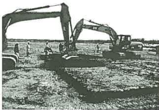
写真-6.4 現地試験状況-2
