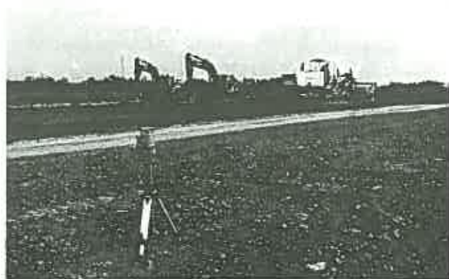
写真-6.7 本施工状況-2
