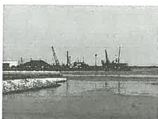
写真-11 霧多布港建設工事（H15年度施工）
