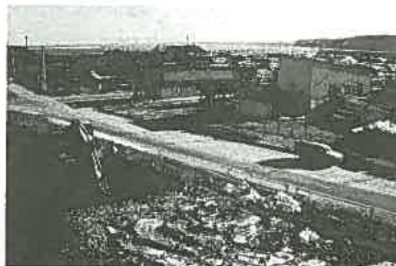
写真-5 木材ストックヤードおよび隣接する一般道
