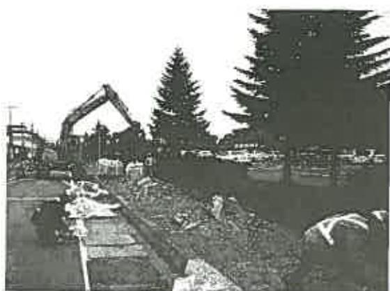
写真-10 上士幌町役場前歩道凍上対策で固化処理実施
