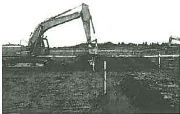
写真-6.3 現地試験状況-1
