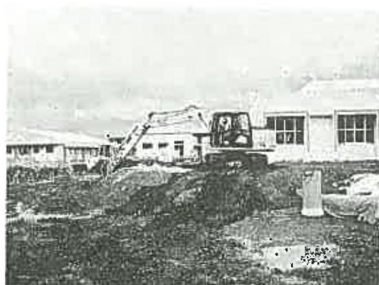
写真-9 北海道紋別養護学校きたみ学園分校改築工事
