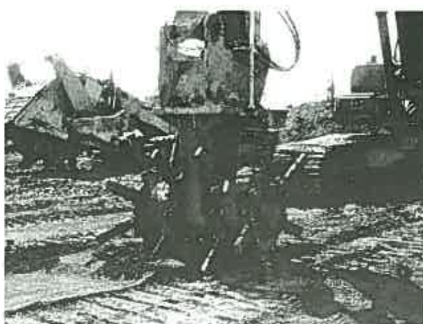
写真-6.6 スタビライザ攪拌ヘッド
