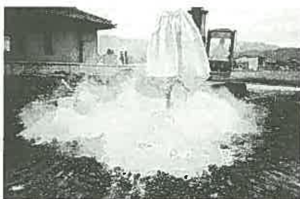
写真-3 一般のセメント系固化材による散布工
