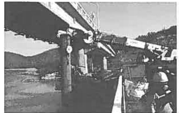
写真-6 鋼管矢板建込 (桁下部)
