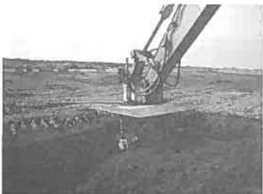
写真-8 レーザーレベルによる攪拌深さ管理
