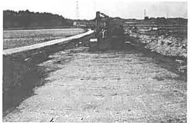
写真-6 改良天端部整形状況
