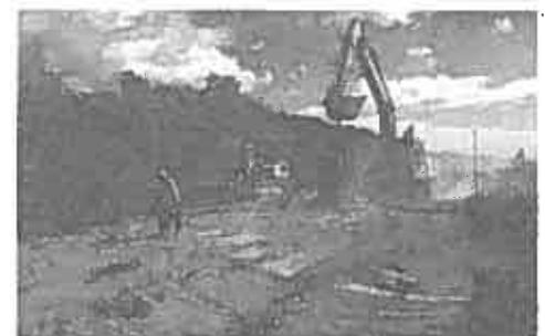
(b)人力による固化材の混合
