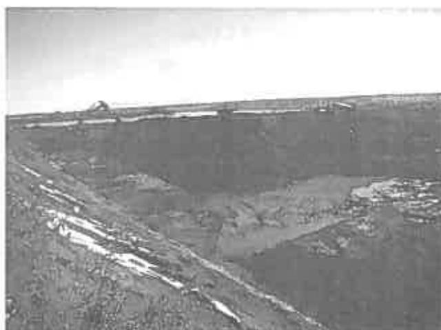
写真-5 砂土取場の集積曝気乾燥(9/15撮影)
