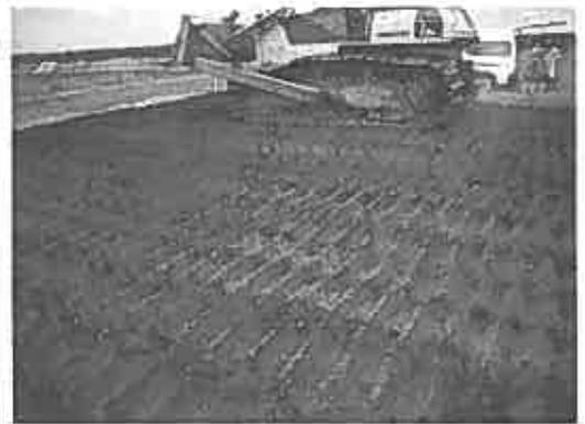
写真-3 試験盛土時の敷均し・転圧状況
