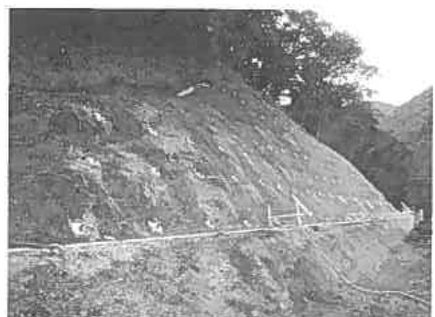
写真-4 高強度ネット工完了
