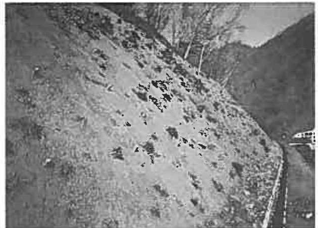
写真-9 中段法面の近景(施工後 1 ヶ月)
