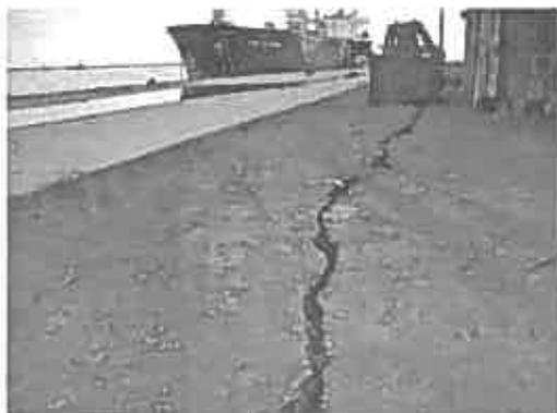
写真-8 地盤改良未施工区域<sup>3)</sup>
