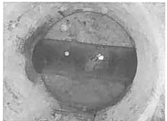
図-15 インバートコンクリート復旧状況
