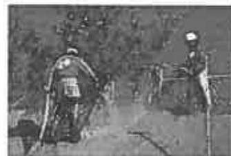
写真-11 連続繊維補強土の施工
