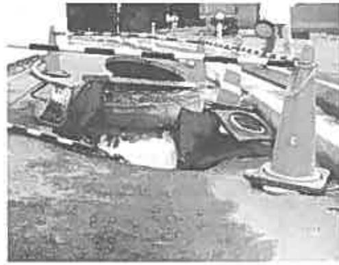
図-2 平成 16 年新潟県中越地震人孔浮上
