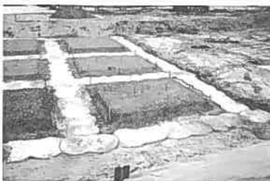
写真-5 TOFT 工法の出来形<sup>4)</sup>
