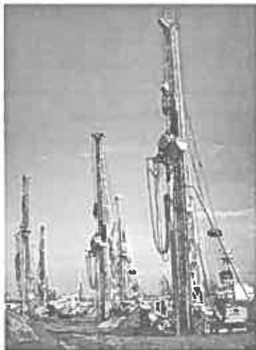
写真-3 SCPの施工状況<sup>4)</sup>
