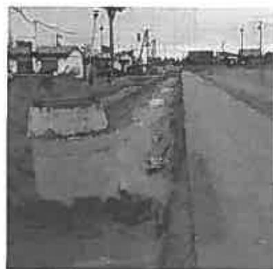
写真-2 液状化によるマンホールの浮き上がり<sup>3)</sup>
