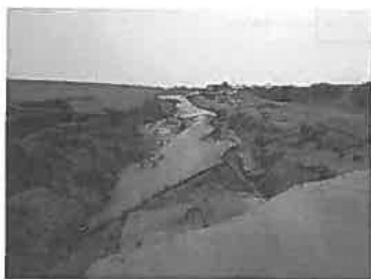
写真-1 液状化による河川堤防の被災<sup>3)</sup>
