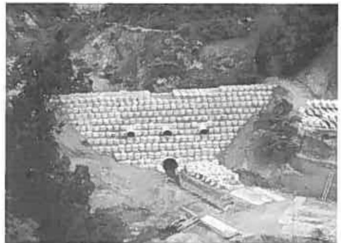
写真-9 仮締切り (土囊) 堤
