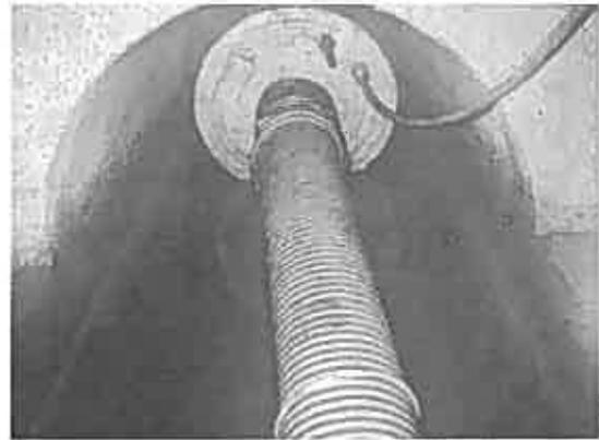
図-10 水替え用止水プラグ (通水管付き)
