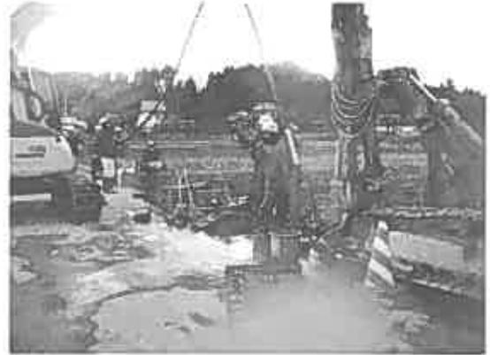
図-13 アンカーテンドン挿入状況
