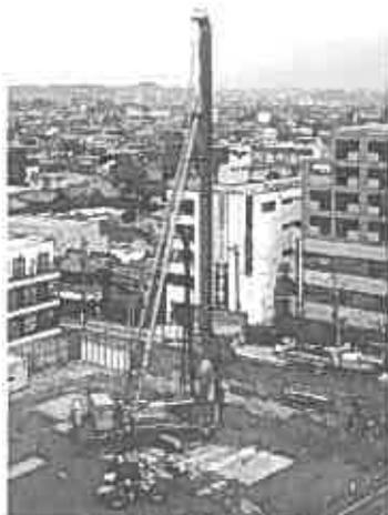
写真-4 SAVE コンポーザーの施工状況<sup>4)</sup>
