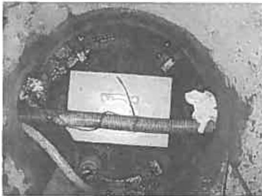
図-14 アンカープレート設置状況
