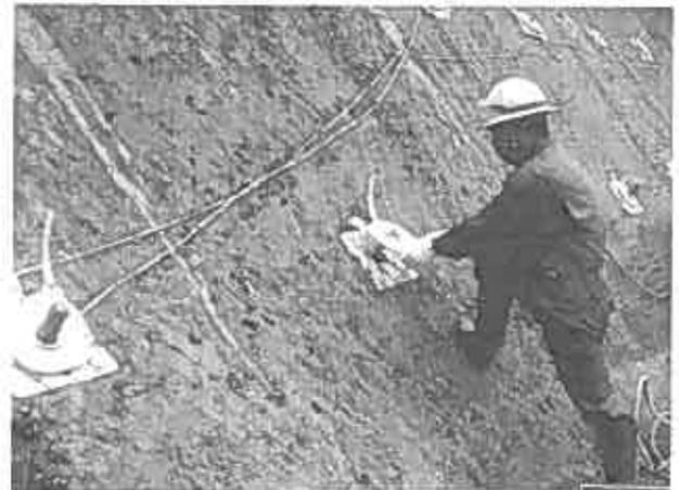
写真-2 クモプレート設置
