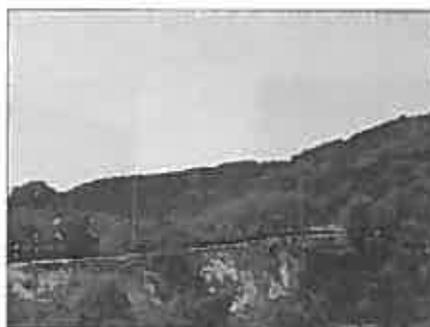
写真-13 道路側の崩壊斜面
