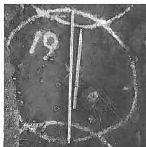
写真-12 改良コラム杭芯確認
