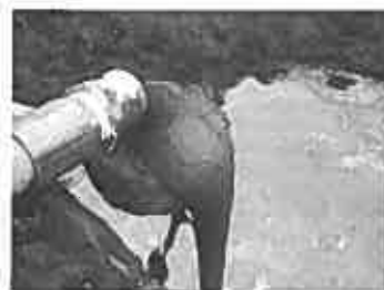
写真-5 パフェグラウトの性状 （合流・混合後）
