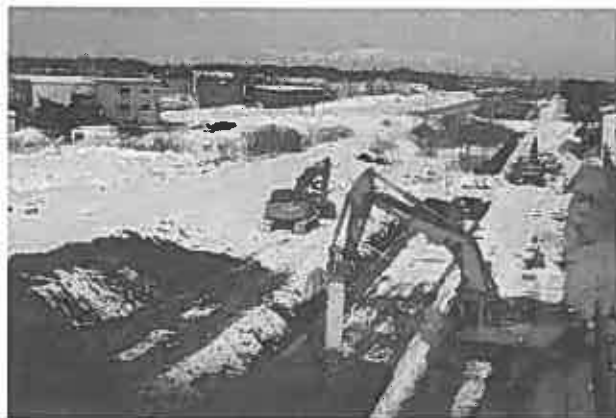
写真-6 TB工法の施工状況
