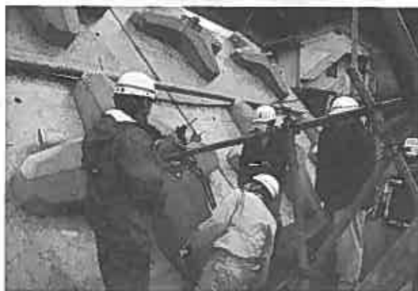
(b) SAAM ジャッキによるリフトオフ試験
