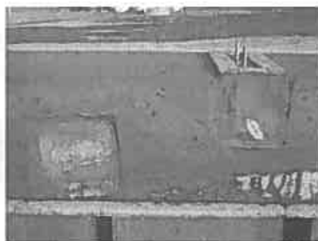
写真－6 角材等周辺の充填状況
