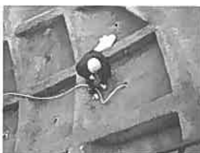
写真－16 既設法面の例
