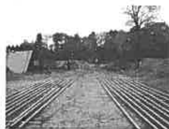
写真-4 圧送に用いた鋼管
