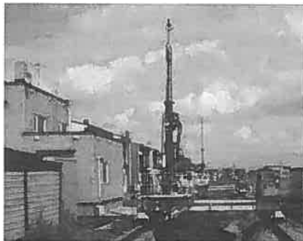
写真-1 機械攪拌併用低変位高圧噴射工法
