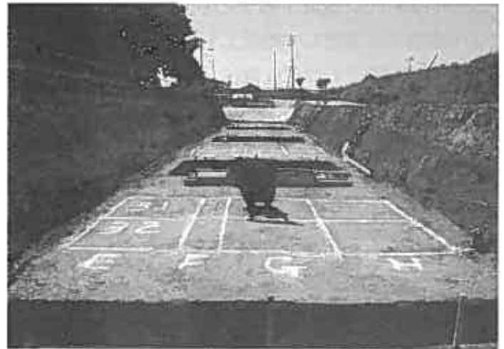
写真－8 T B 施工後の改良部掘削面状況
