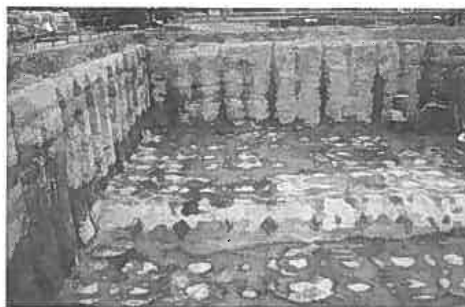
写真-2 掘削状況
