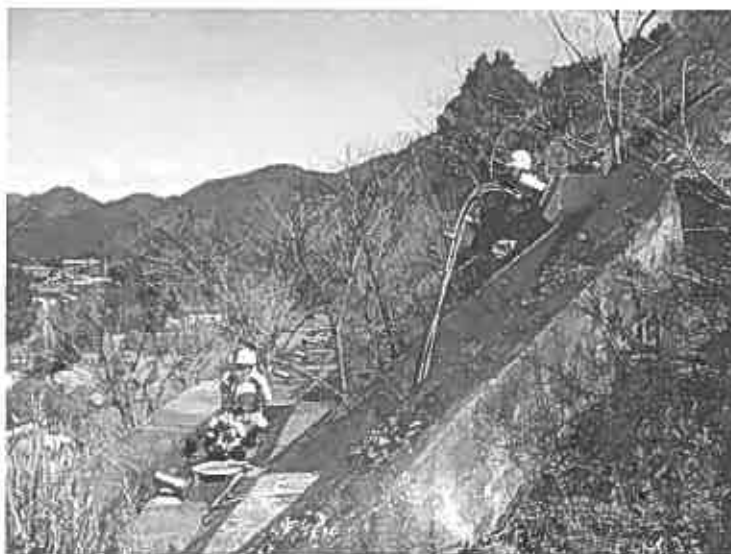
写真－6 リフトオフ試験状況
