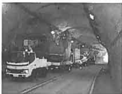
写真－12 道路トンネルの例
