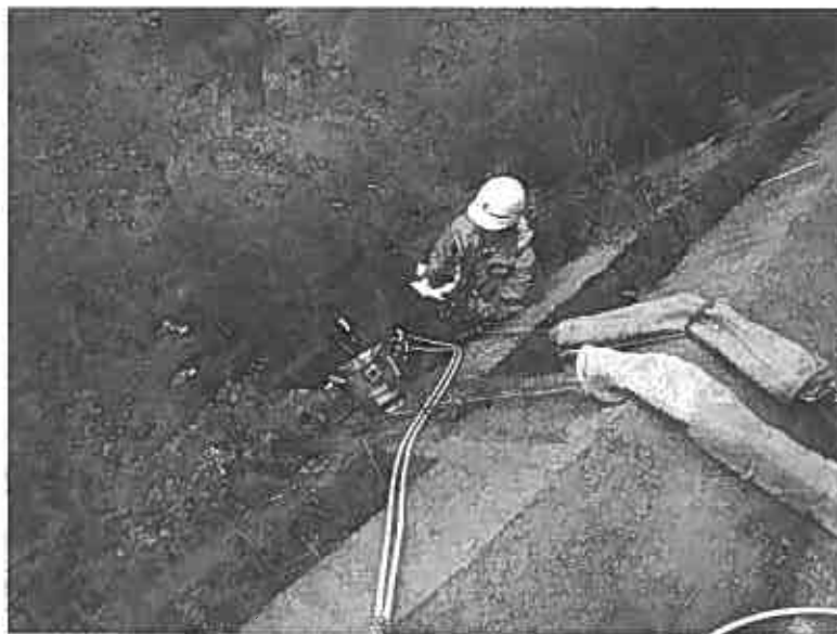
写真-8 リフトオフ試験状況
