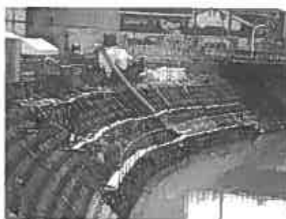
写真－13 河川護岸の例
