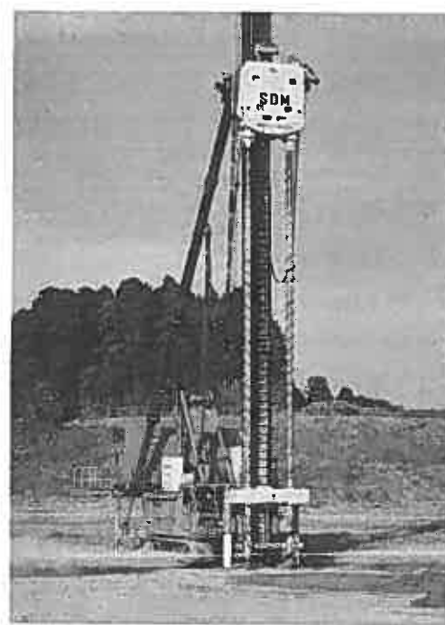
写真-1 SDM工法施工機械と高圧水噴射状況
