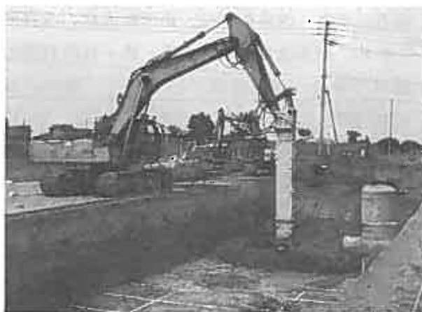
写真-7 既設下水管とマンホール部の近接施工状況
