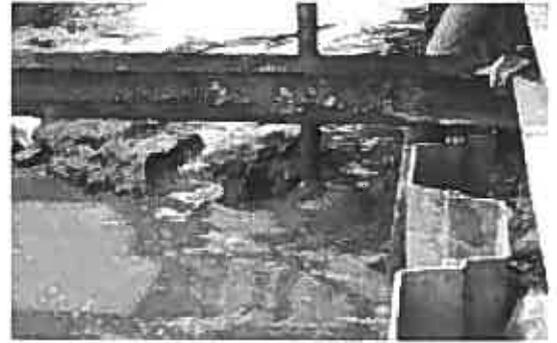
写真-6 NJP施工による排泥土排出状況
