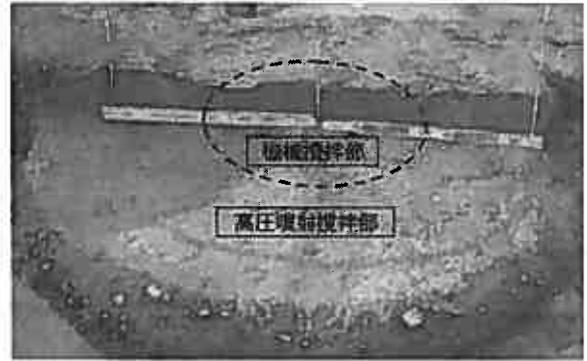
写真-5 杭頭部切断面状況
