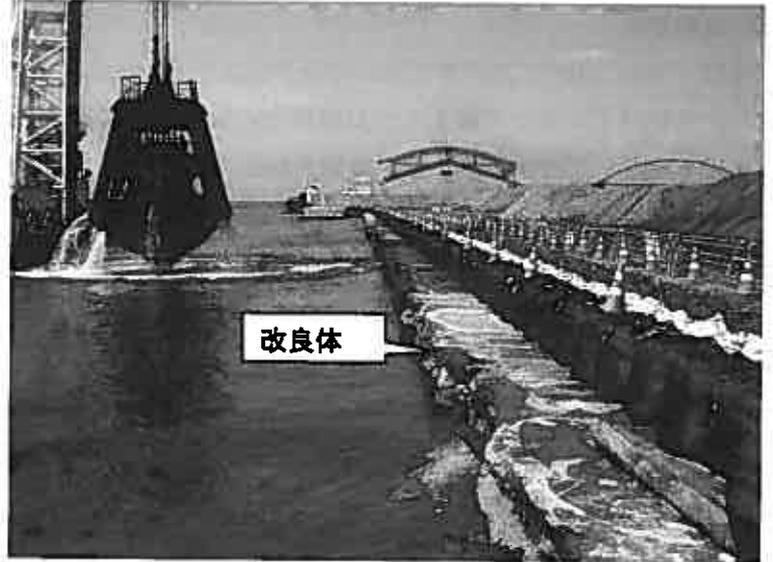
写真-2 旧岸壁の取り壊し掘削工状況写真
