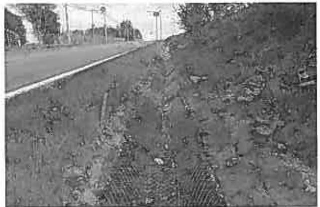
写真-1 浸透側溝 AタイプとBタイプの繋ぎ
