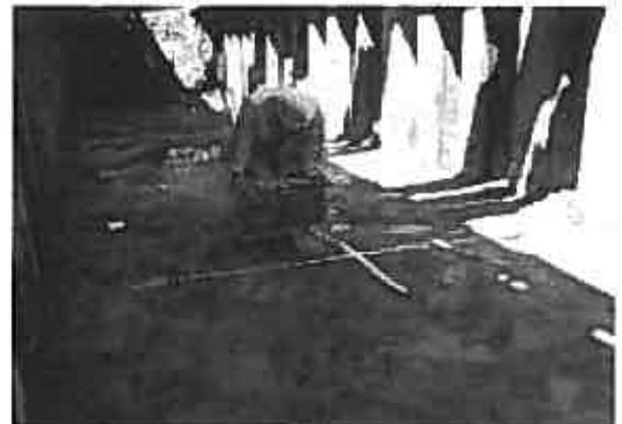
写真-7 水路部開削によるNJP改良確認状況
