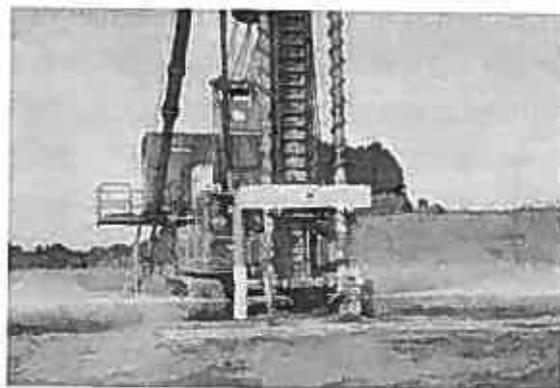
写真-1 SDM 攪拌翼先端からの超高压噴射状況
