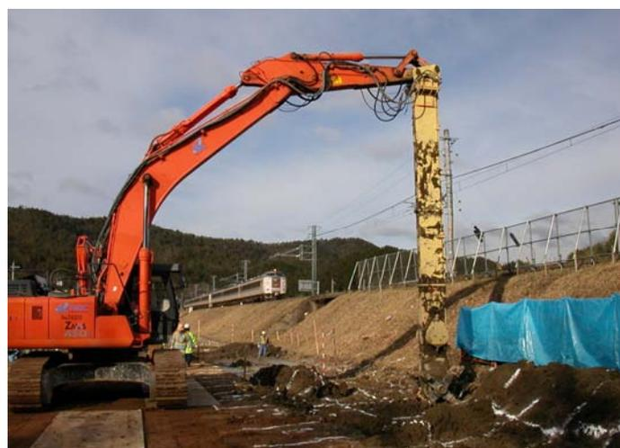
写真-1 鉄道近接部による TB 施工状況
