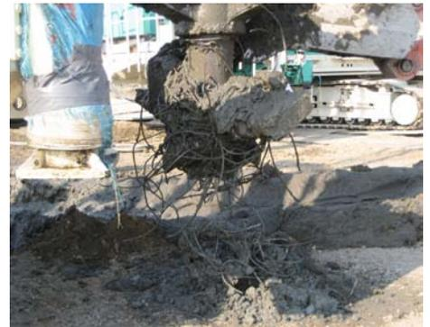
写真-5 攪拌翼によって破断したPC鋼線
