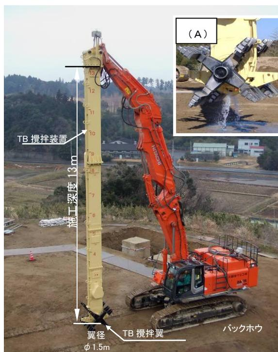
写真-2 TB14M型長尺施工機
