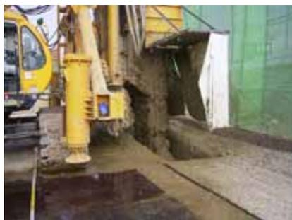
写真-5 掘削液による掘削状況
