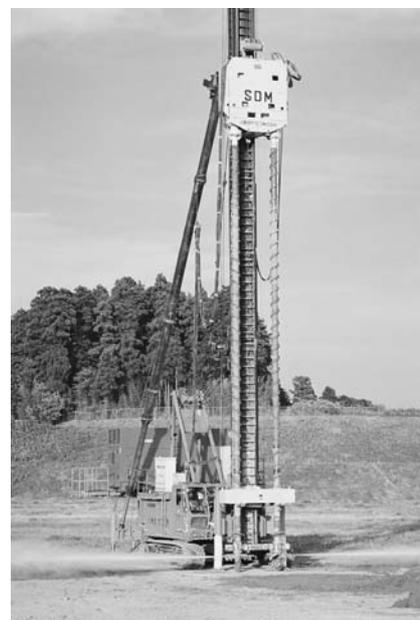
写真-1 SDM-Dy 施工機と高圧水噴射状況
