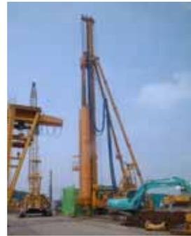
写真-4 柱列式地中連続壁工法
