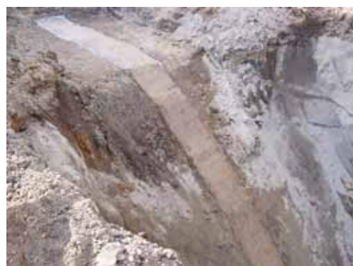
写真-1 等厚施工機を用いた EC ウォールの出来形断面
