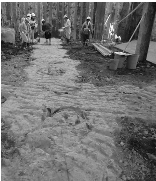
写真-2 床付け部の SDM-Dy 改良体状況
