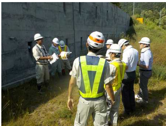
H25 年盛土崩壊 対策箇所 (KP34.4) グラウンドアンカー、水抜きボーリング
