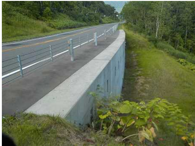
H24年盛土崩壊対策箇所 (KP40.8) グラウンドアンカー
