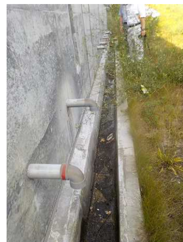
H25 年盛土崩壊 対策箇所 (KP34.4) 排水状況
