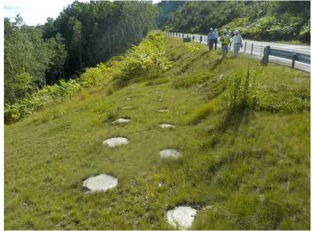
H24年地すべり対策箇所 (KP40.6) 抑止杭工
