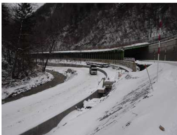
写真 5-3 洗掘を受けた擁壁（視察時）
