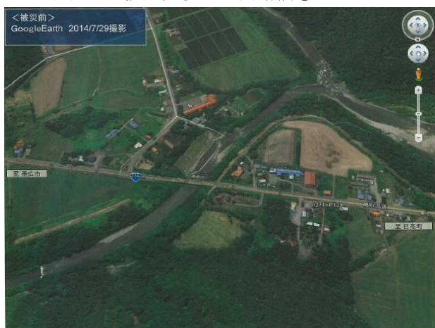
写真 7-5 被災前の千呂露橋（遠景）
