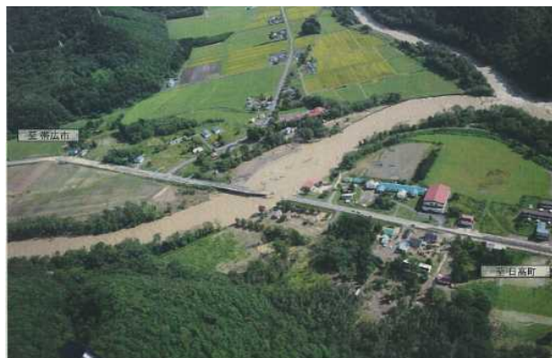
写真 7-4 被災直後の千呂露橋②（遠景）
