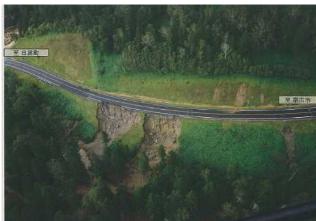
写真 2-2 盛土のり面表層崩壊（遠景：被災直後）
