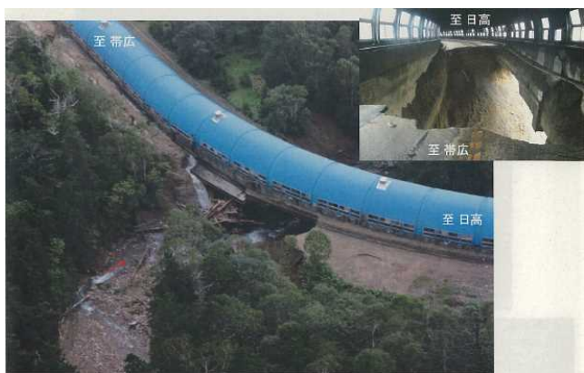
写真 1-3 三国の沢覆道（遠景：被災直後）
