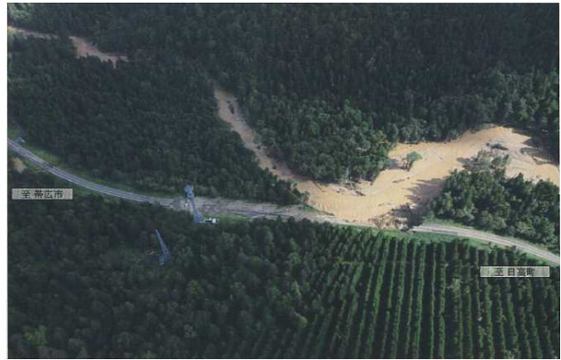
写真 3-2 道路盛土の洗掘による被災（遠景：被災直後）
