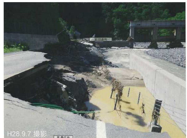
写真 4-2 橋台背面・盛土の洗掘（被災直後）
