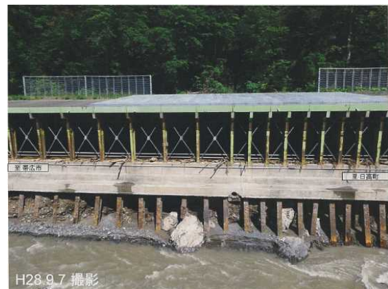
写真 5-2 洗掘を受けた覆道（被災直後）
