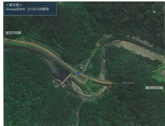
写真 4-4 橋台背面・盛土の洗掘（遠景：被災前）
