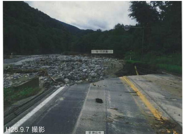
写真 6-2 洗掘を受けた盛土（被災直後）
