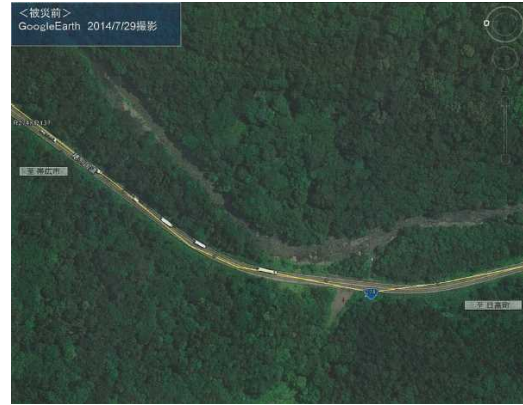
写真 6-4 洗掘を受けた盛土（遠景：被災前）
