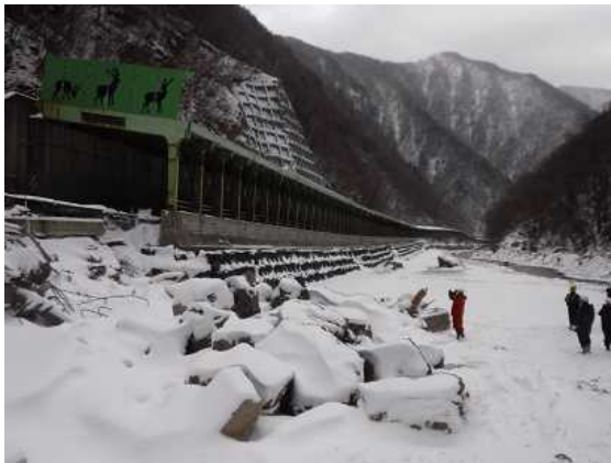
写真 5-1 洗掘を受けた覆道（視察時）
