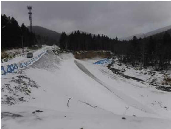
写真 3-1 道路盛土の洗掘による被災（視察時）
