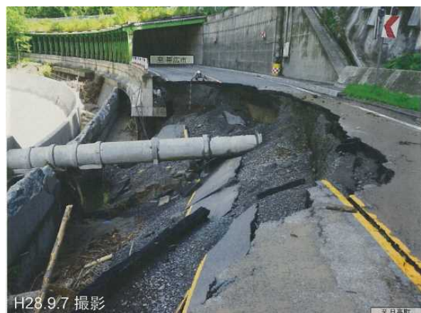
写真 5-4 洗掘を受けた擁壁（被災直後）
