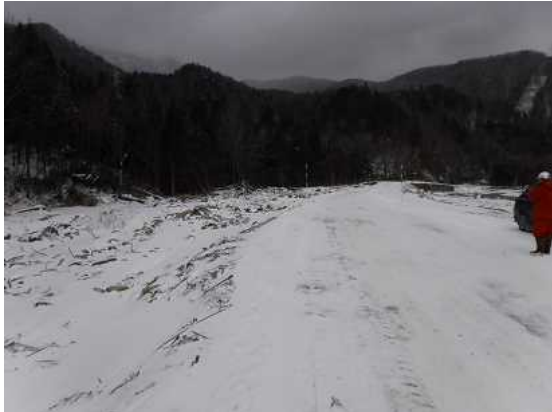
写真 6-1 洗掘を受けた盛土（視察時）
