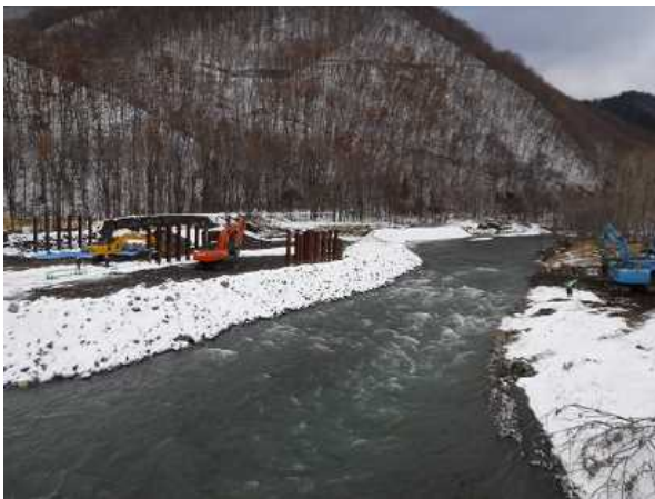
写真 7-1 千呂露橋の復旧工事（視察時）
