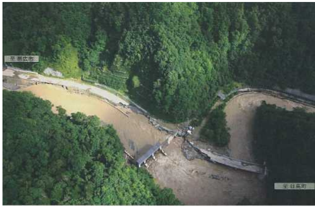
写真 4-3 橋台背面・盛土の洗掘（遠景：被災直後）
