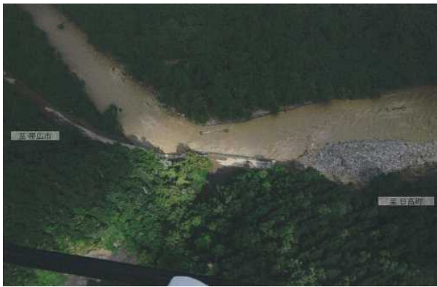
写真 6-3 洗掘を受けた盛土（遠景：被災直後）
