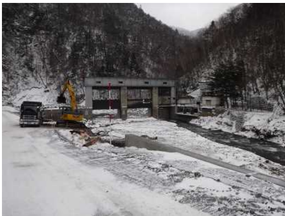
写真 4-1 橋台背面・盛土の洗掘（視察時）
