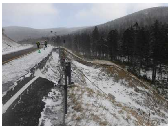
写真 2-1 盛土のり面表層崩壊（視察時）
