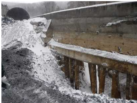
写真 1-1 三国の沢覆道（視察時）
