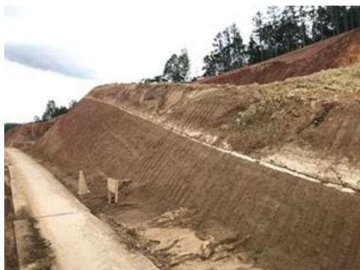
写真1 排土前の地すべり面
