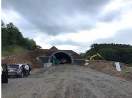
写真3 ソイルセメント盛土におけるトンネル
