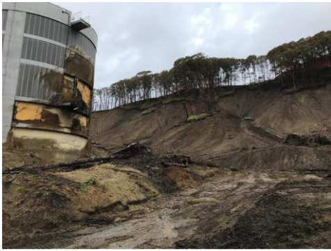
写真3 富里浄水場背面の斜面崩壊
