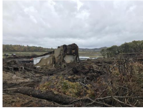
写真4 富里浄水場タンクに接続していた階段
