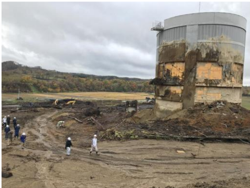
写真5 タンク上層部まで付着する土砂
