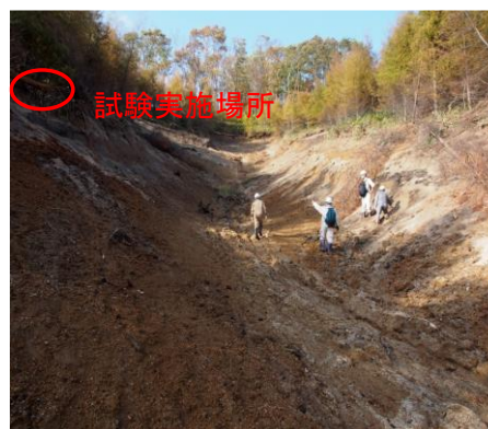
写真8 試験実施箇所
