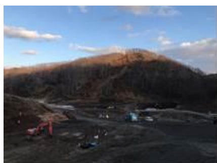
写真1 被災箇所の現状
