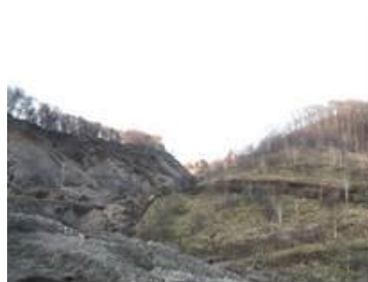
写真2 側面からみた崩壊箇所
